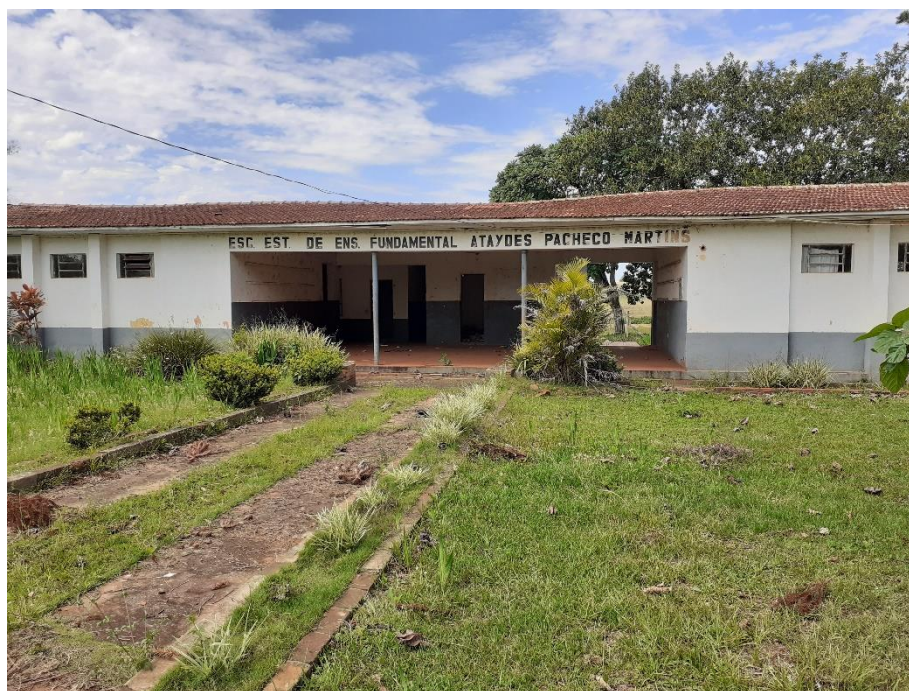
Figura 10 – Prédio da escola desativada em Linha Silva Jardim, Cândido Godói/RS
