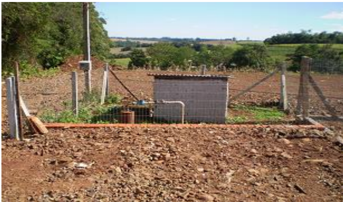
Figura 11 – Foto do Reservatório com Hidrojetor para Tratamento de Cloro e Flúor
