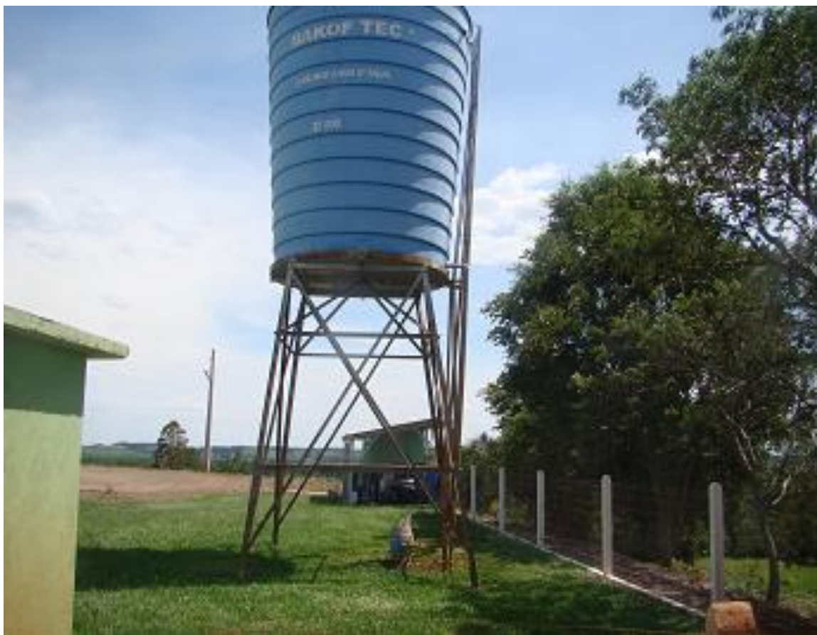
Figura 11 – Foto do Reservatório com Hidrojetor para Tratamento de Cloro e Flúor
