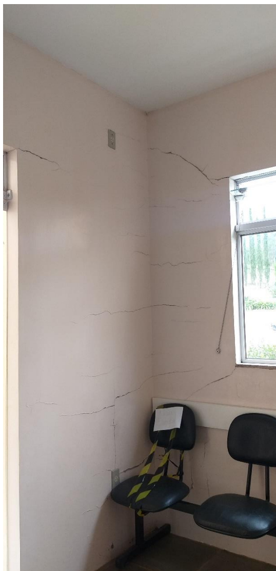
Foto 1: Ponto de recalque diferencial sofrido pela estrutura.
