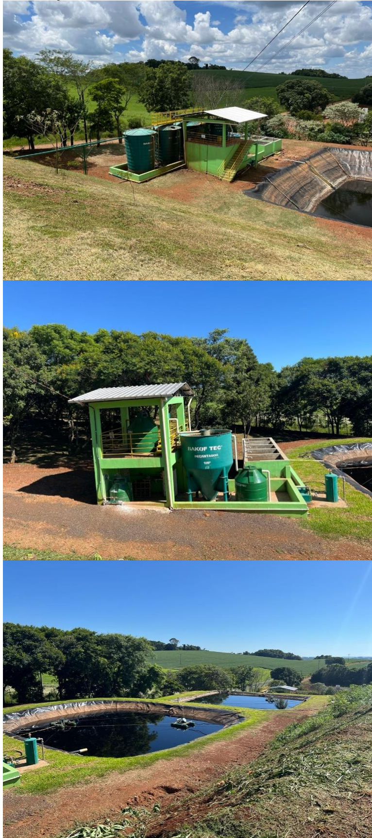
Figura 34: Estação de tratamento do efluente/lixiviado.
