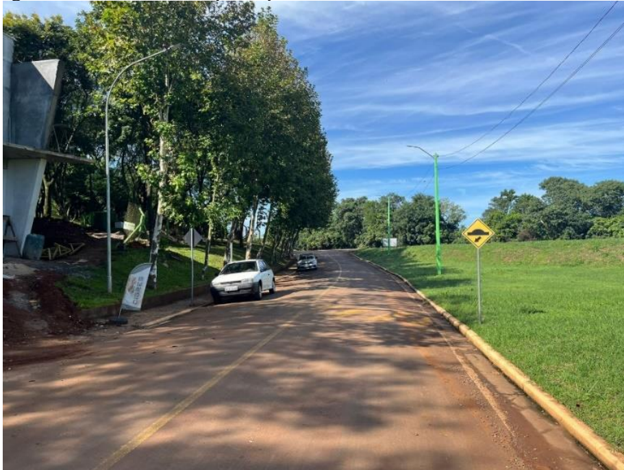
Figura 17: Via de acesso principal.
