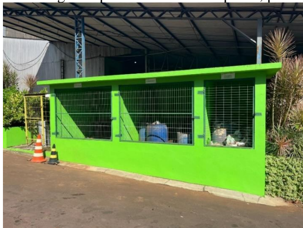
Figura 20: Local designado para armazenar lâmpadas, pilhas e baterias.
