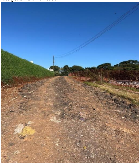
Figura 48: Pavimentação de vias.
