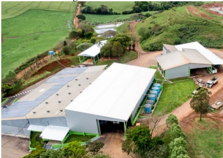
Figura 26: Pavilhão de triagem.
