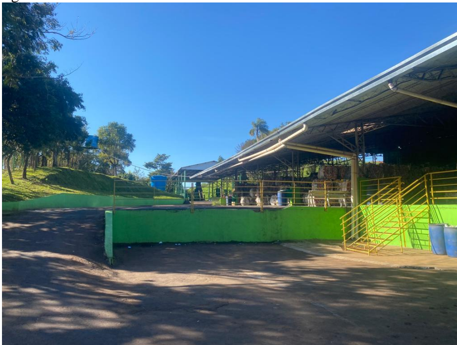
Figura 18: Vias do consórcio com massa asfáltica.
