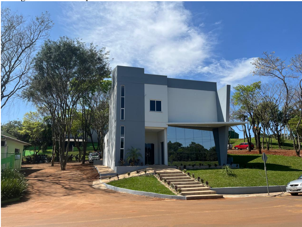
Figura 24: Construção do auditório e escritório.
