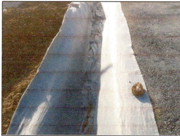
Figura 02: Exemplo da aplicação da manta geotêxtil
