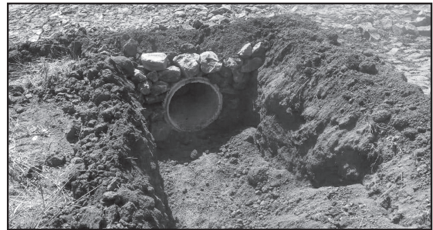
Instalação de bueiro em linha Alma
