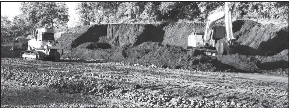
Execução de serviços na área destinada a shows do parque de eventos
