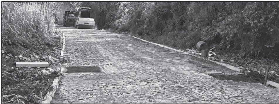
Compactação do calçamento em linha Torta
