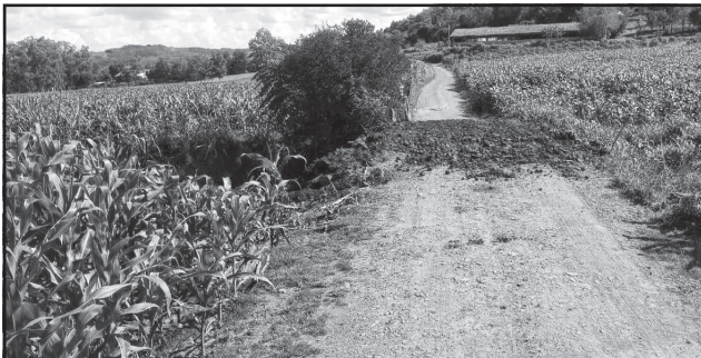
Recuperação de cabeceira de ponte em linha Doze de Maio
