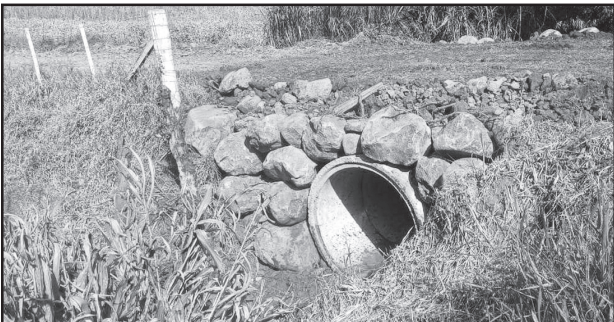
Substituição de ponte de madeira por tubos de concreto em linha Divisa
