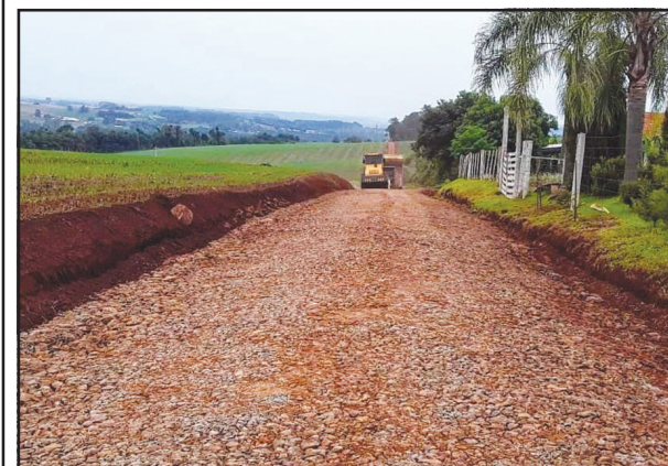
Recuperação de estrada no trecho entre BR 472 e o cemitério de linha Salto
