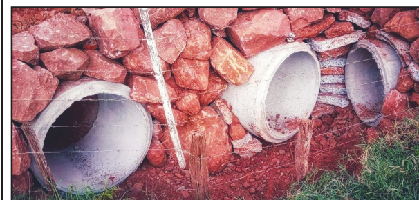
Instalação de tubulação e conserto de boca-de-lobo em linha Taquaruçu
