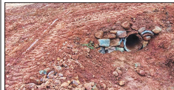
Limpeza de bueiro na estrada entre as linhas Bom Princípio Alto e Guaraipo
