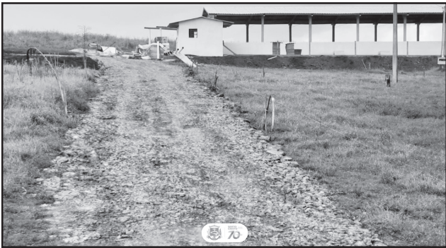
Melhoria do acesso com encascalhamento para Jair Becker, em Linha Dona Belinha
