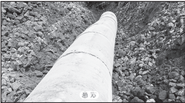
Colocação de tubos em Bom Princípio Baixo
