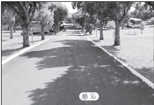
Limpeza e pintura do parque de eventos
