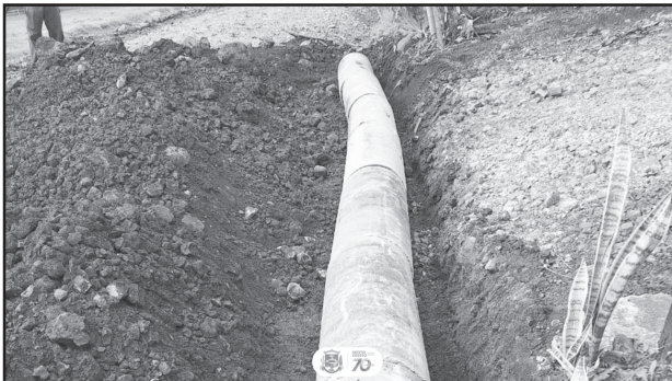
Melhoria do acesso com colocação de tubos para Rogério Kieling, em Bom Princípio Baixo
