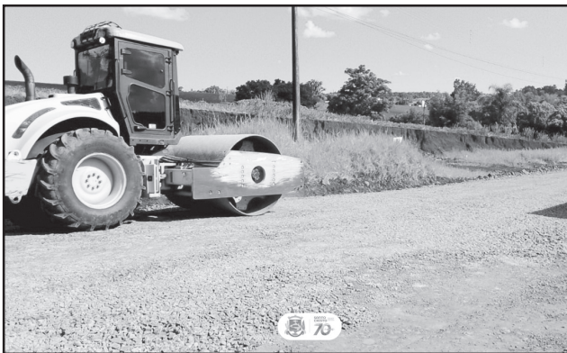
Manutenção e cascalhamento nas ruas de acesso à cidade
