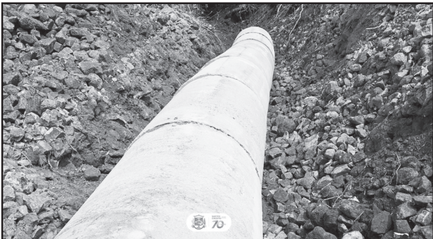
Colocação de tubos em Bom Princípio Baixo
