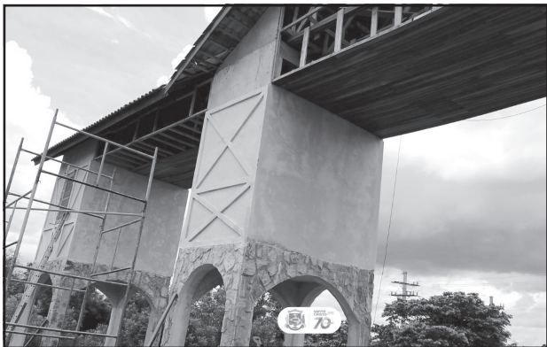
Obras no pórtico da Avenida Celso Antônio Hartmann
