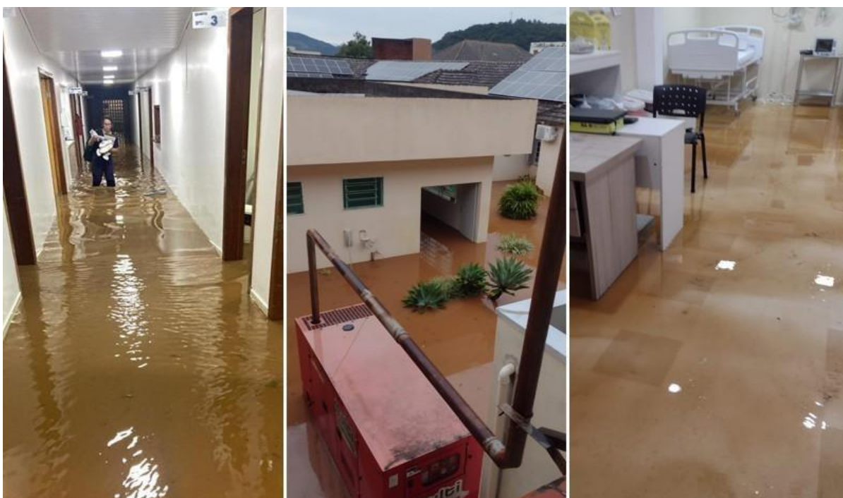
Figura 10. Consequências na infraestrutura pública causados pela enxurrada registrada em 2024
