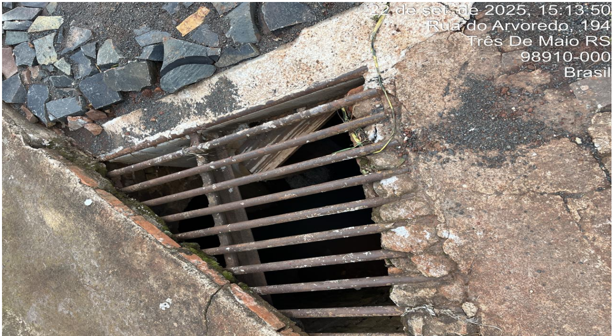
Imagem 3: Boca de lobo existente, a ser ampliada.
