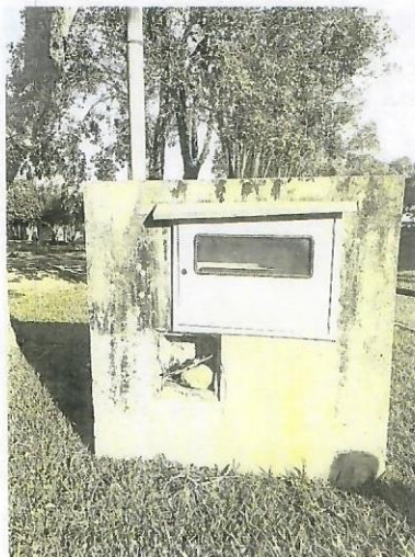
Figura 6 - Entrada de energia a ser demolida
