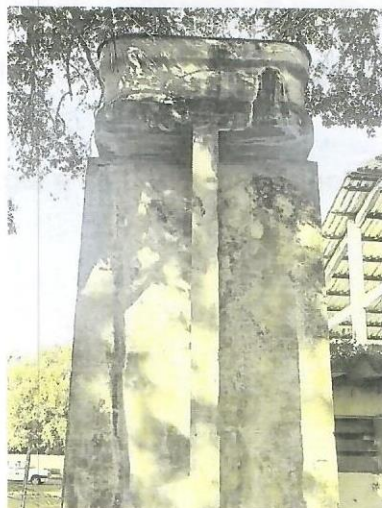
Figura 9 - Caixa da água existente.
