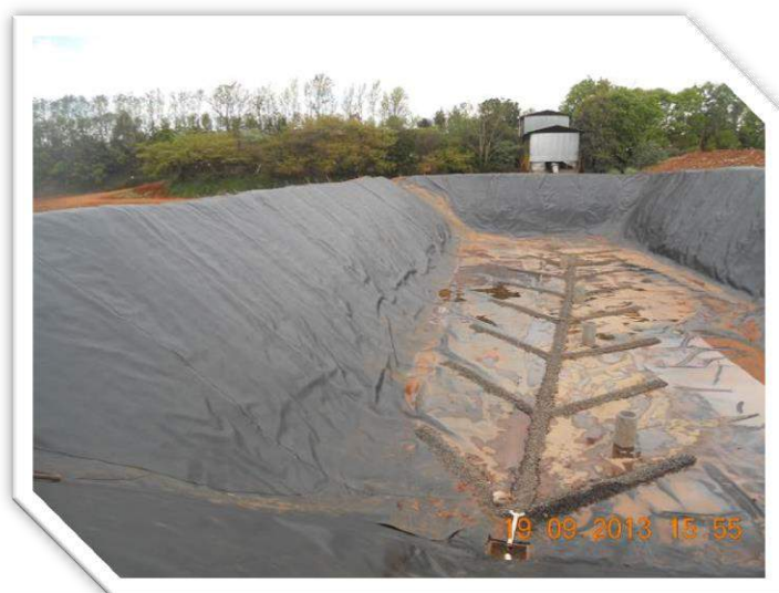
Fotografia 9 - Vala em construção com sistema de drenagem estilo espinha de peixe
