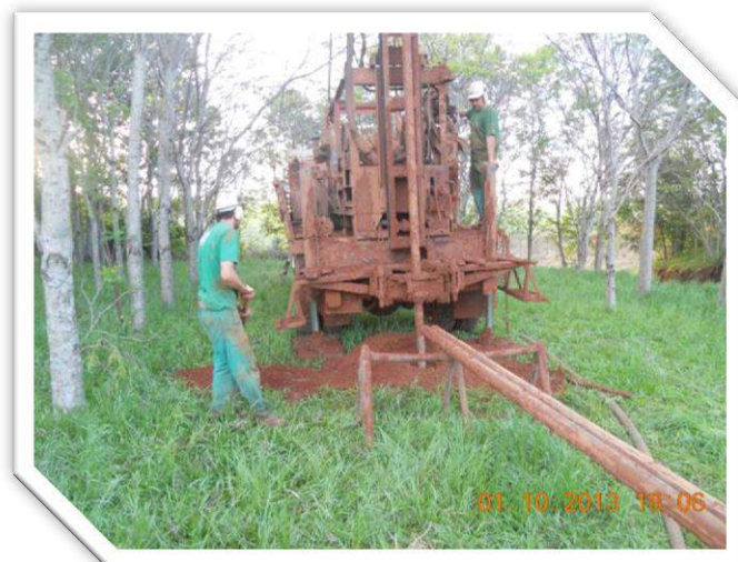
Fotografia 10 - Perfuração de um dos poços para o monitoramento do lençol freático Fonte: Arquivos do CITEGEM/2013.
