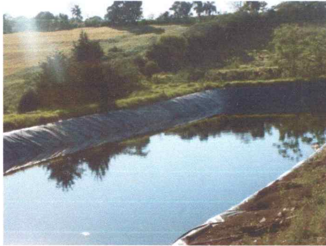
Figura 26. Lagoa de retenção do lixiviado.
