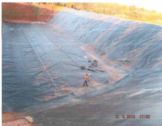
Figura 25: Geomembrana de cobertura da célula de aterro.
