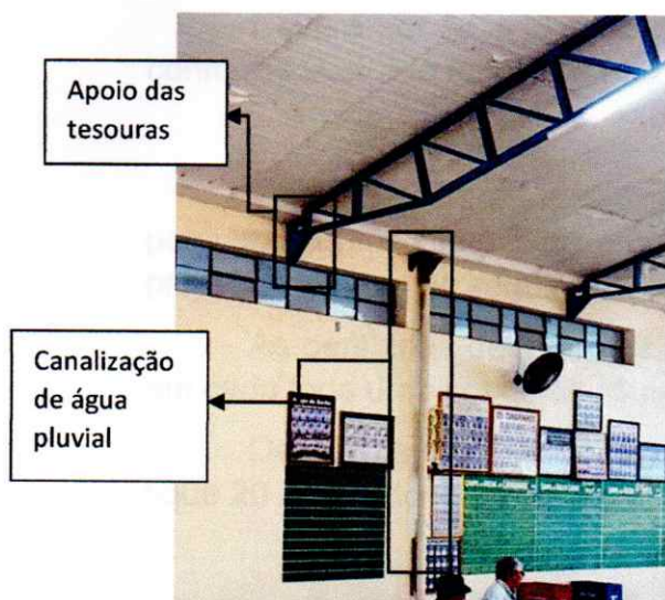
Figura 01- Ilustração do apoio das tesouras e canalização de água pluvial existentes
