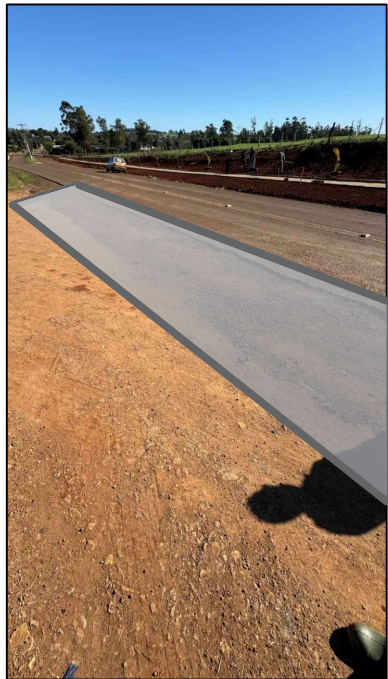
CONCRETAGEM PARA CONDUZIR A ÁGUA
