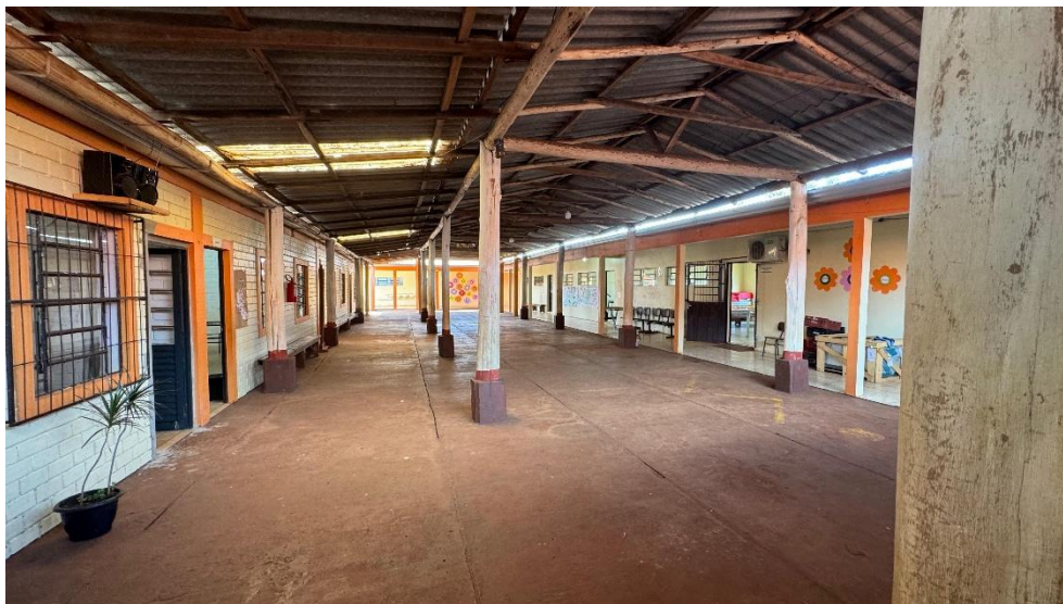
Saguão entre prédios atual – EMEF Mariuza da Silva da Silva
