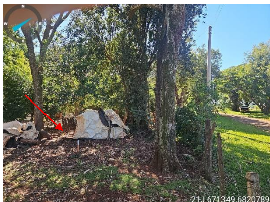
Figura 06. Á área onde será realizada a perfuração do poço. Pode ser observada a existência de rede de energia próxima. A seta indica o local da perfuração.
