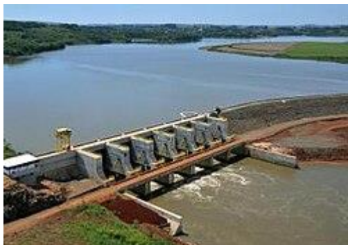
Usina Hidrelétrica Passo São João
