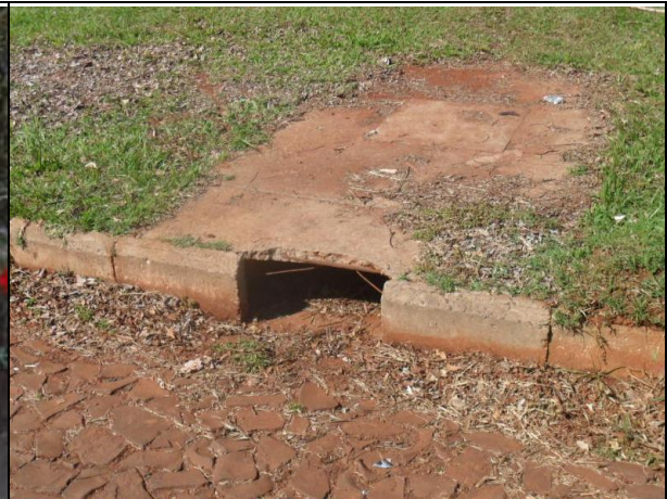
FOTO 02 – Infraestrutura de Drenagem
