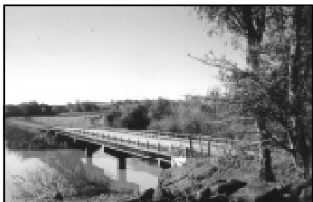
Ponte sobre o Ijuí Mirim
