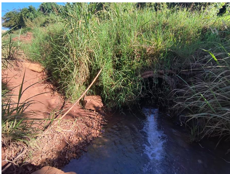
Figura 1 – Trecho Rincão dos Pires, bueiro a ser modificado
