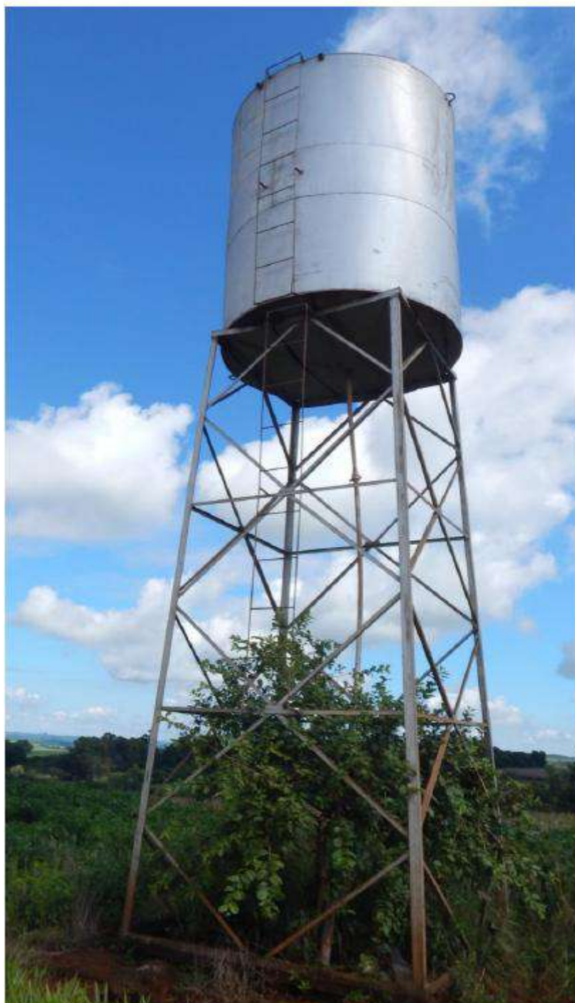
Figura 75. Reservatório de água Rincão dos Correia.
