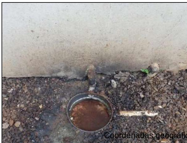
FOTO 03 – Caixa de gordura inadequada
