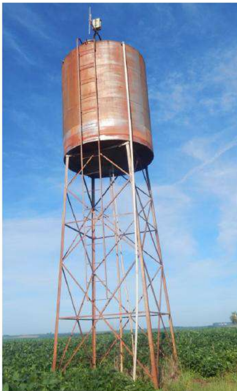
Figura 59. Reservatório de água Capão Grande.
