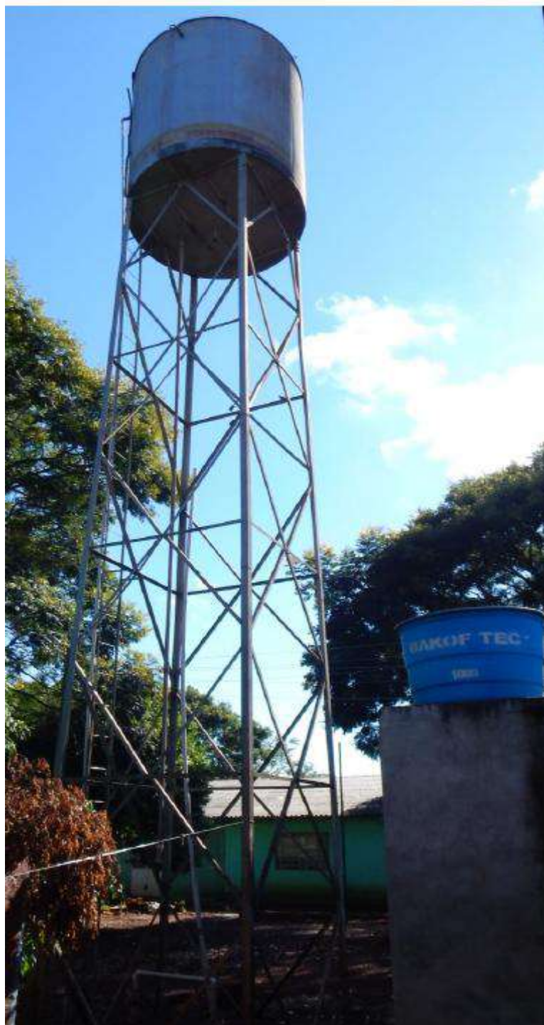
Figura 61. Reservatório de água Rincão dos Brum.
