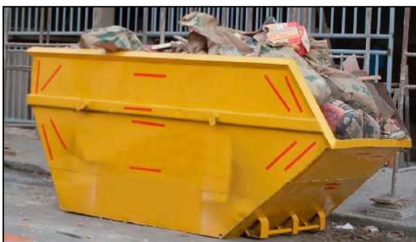
Figura 24. Caçamba contendo RCC
