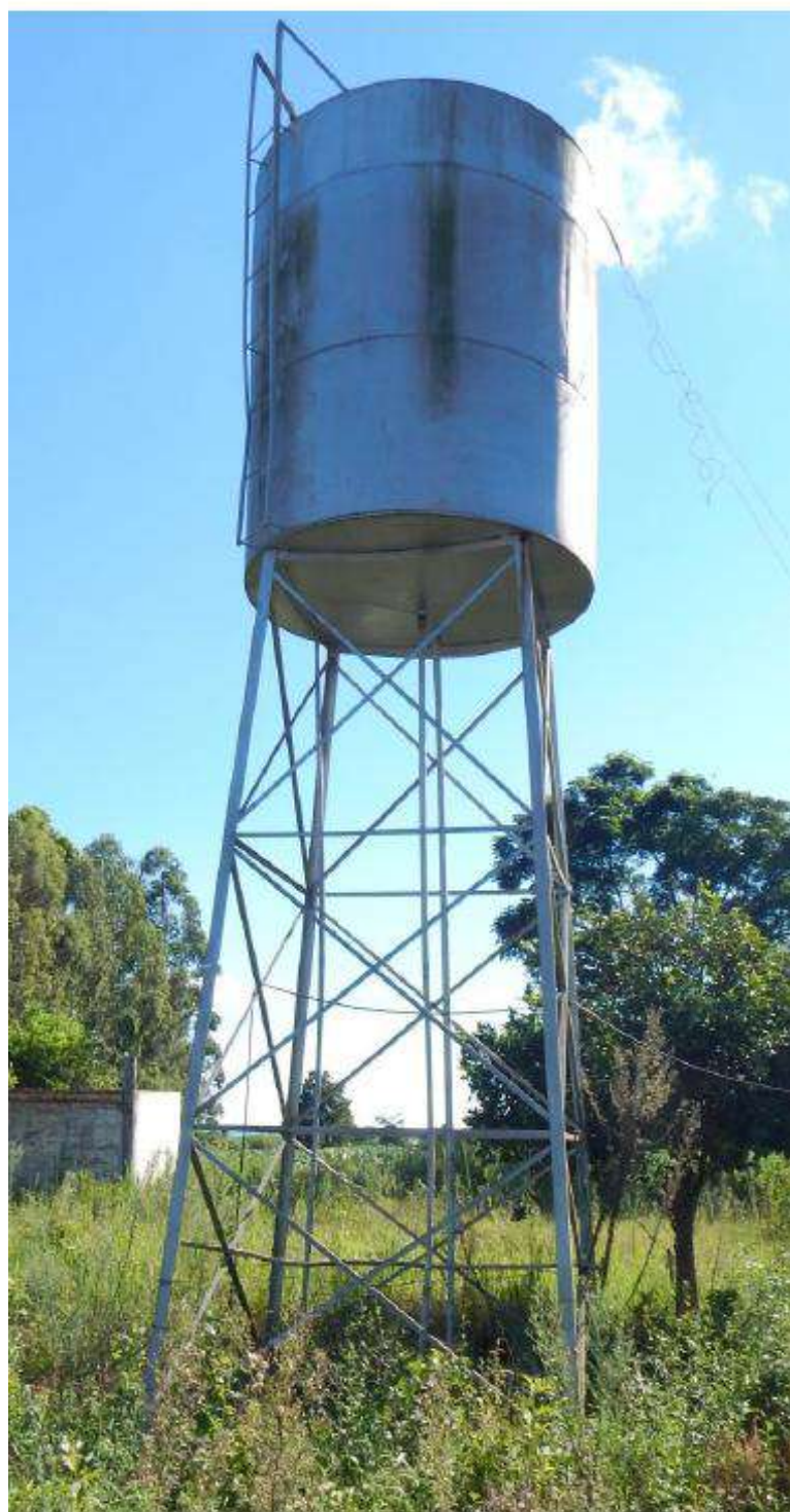
Figura 63. Reservatório de água Vista Alegre.
