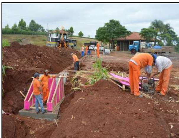
FOTO 05 – Obra de Drenagem
