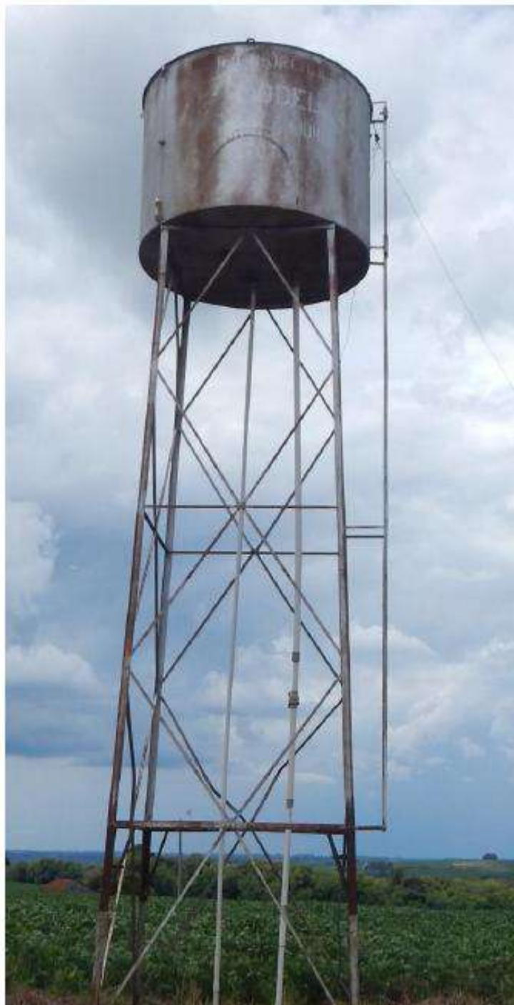
Figura 60. Reservatório de água Rincão Pesqueiro.
