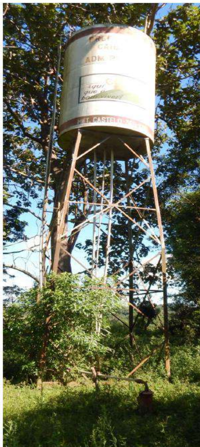
Figura 77. Reservatório de água Rincão dos Correia 2.
