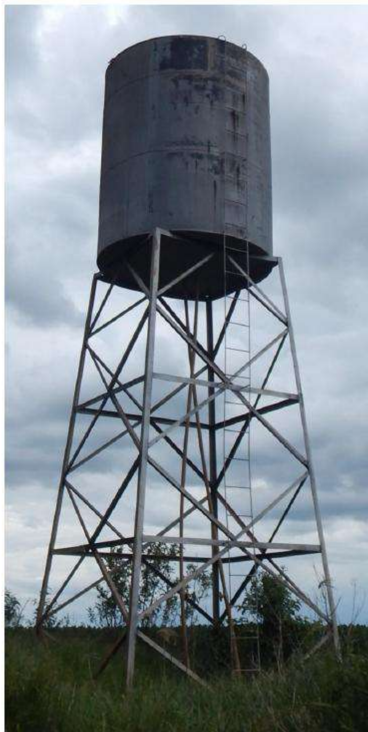
Figura 74. Reservatório de água Serrinha dos Urubucarú.
