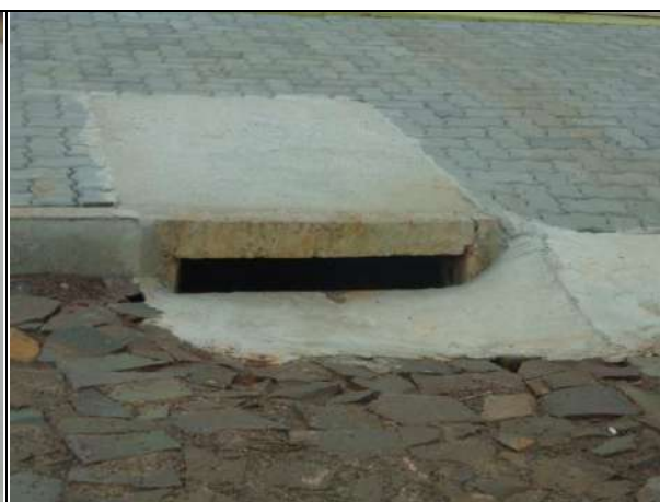
FOTO 04 – Boca de Lobo
