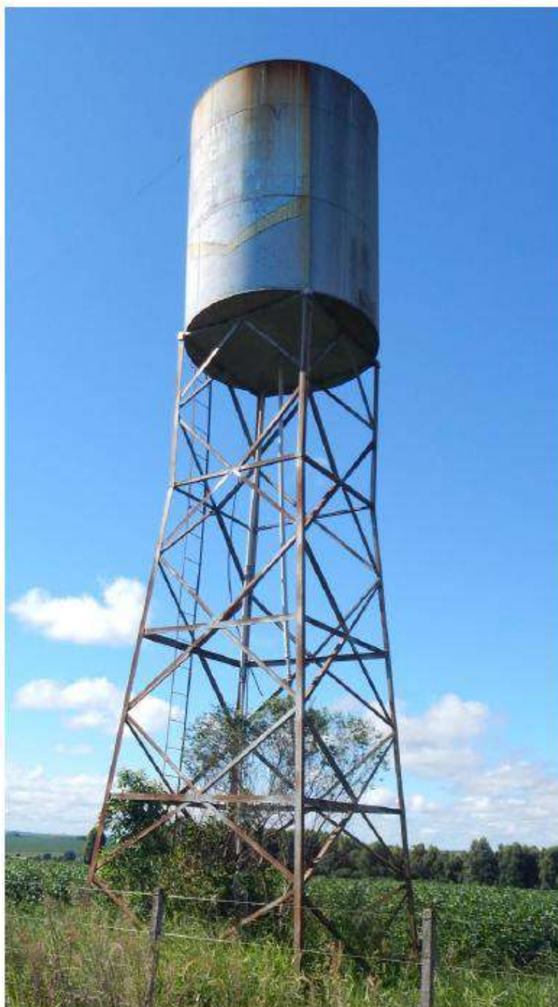
Figura 64. Reservatório de água Rincão dos Machado.
