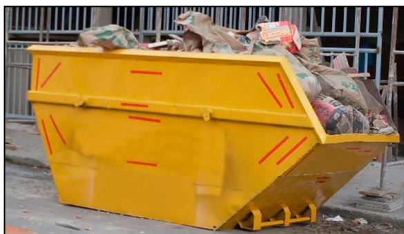
Figura 24. Caçamba contendo RCC
