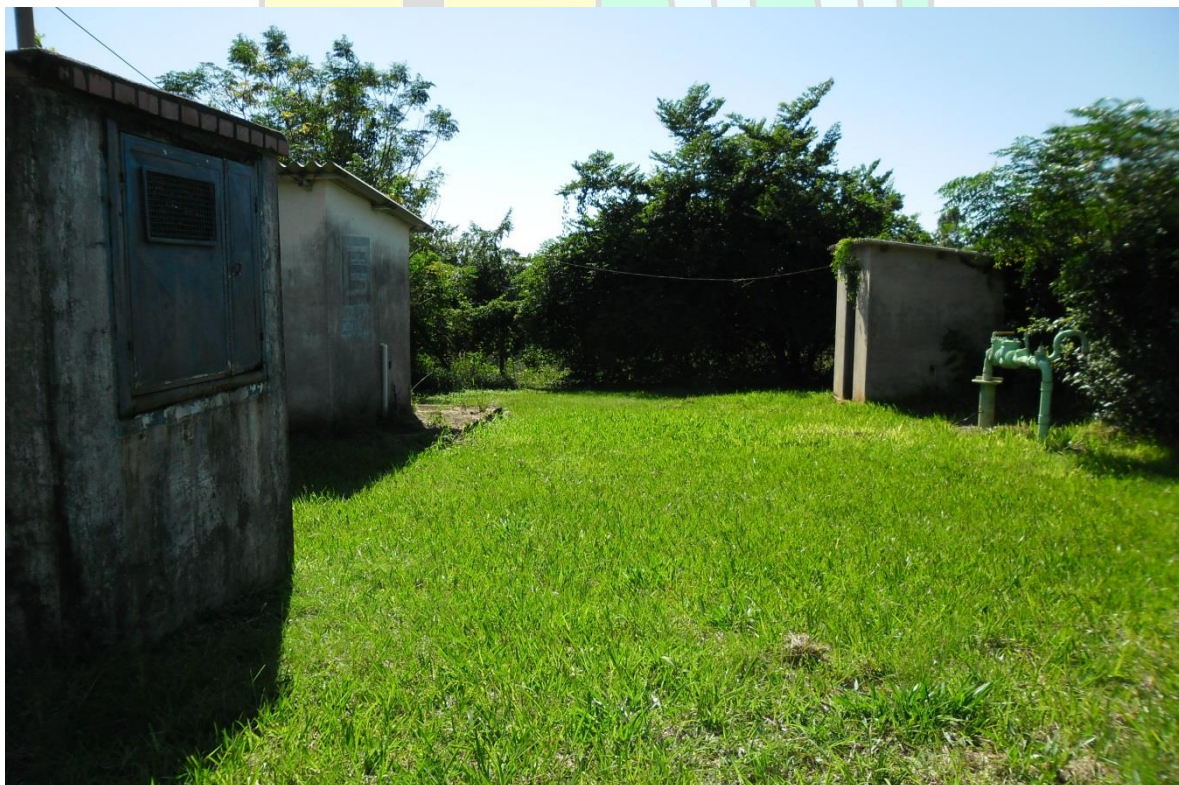
Imagem 18: Ponto de Captação Bairro São Jorge.
