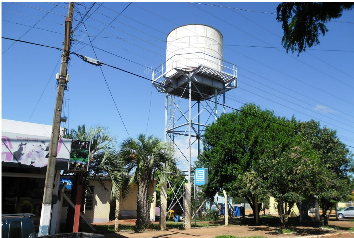
Imagem 20: Reservatório Metálico Elevado.
