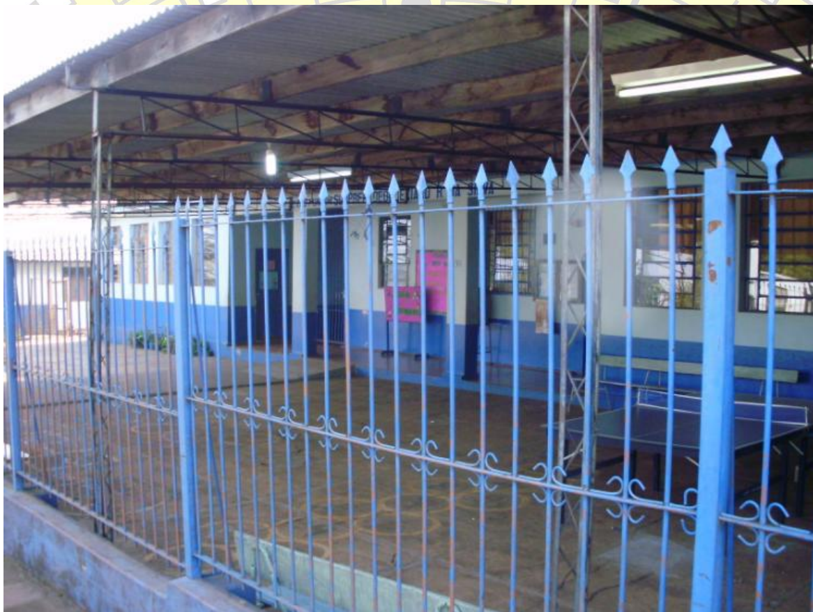
Imagem 08: Escola Municipal de Educação Fundamental Subprefeito Deocleciano Rodrigues da Silva.
