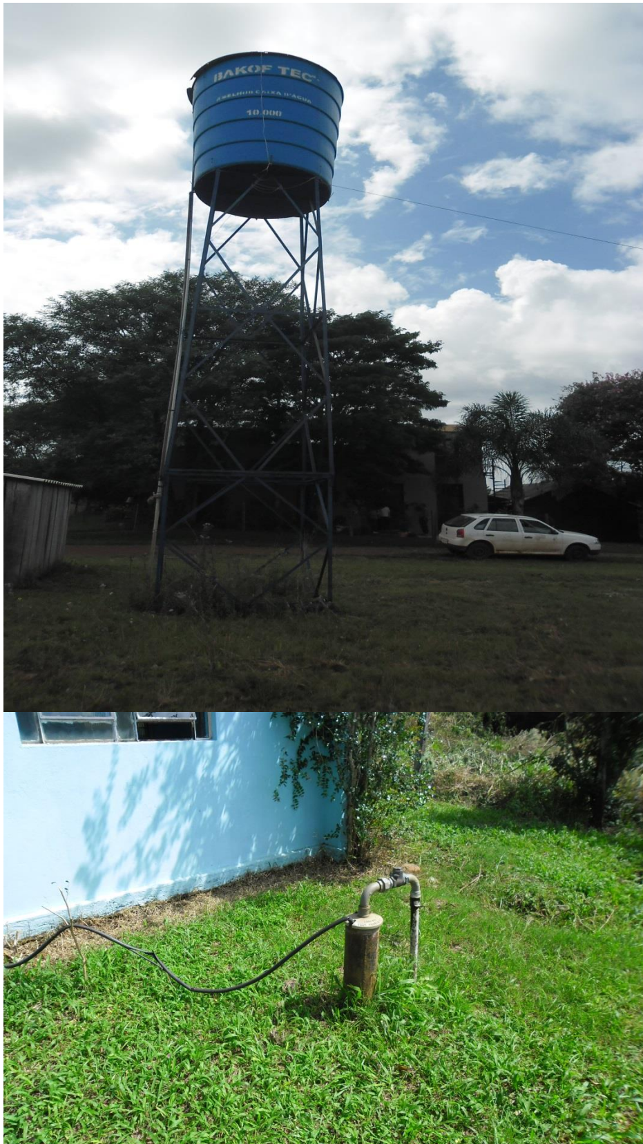
Imagem 26: Poço comunitário Vila Santa Rosa
