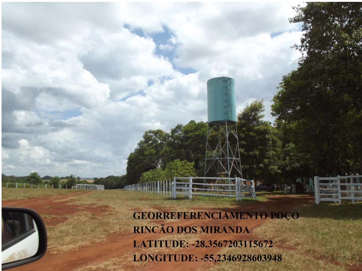
Imagem 21: Poço comunitário Rincão dos Miranda.
