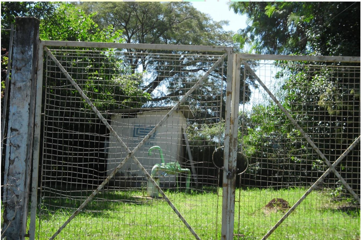
Imagem 16: Ponto de Captação Bairro Santa Catarina.
