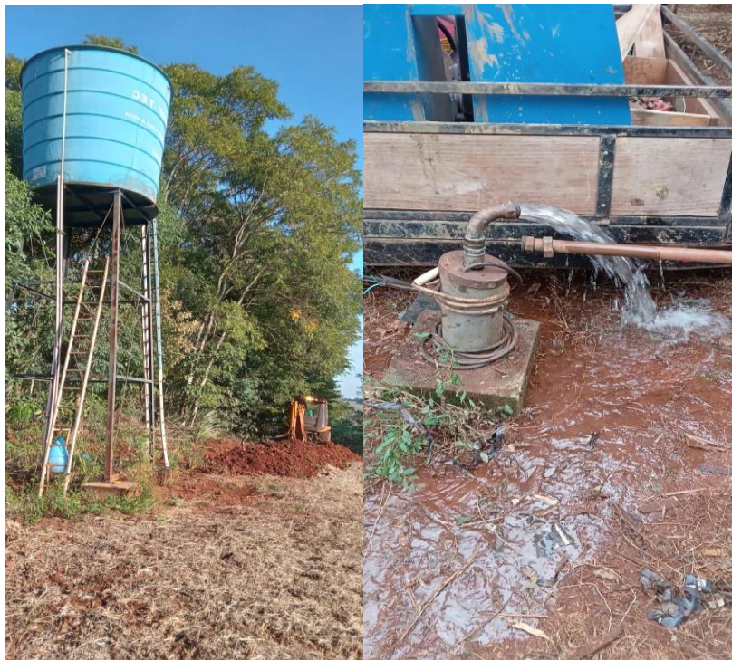
FOTO 06 e 07 Rede nova de Sítio Langner e Substituição de bomba sítio santos
