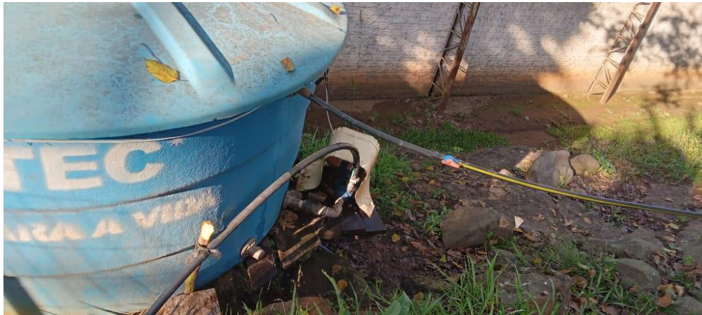
FOTO 04 Conserto de Bomba de Agua Vila Ottonelli
