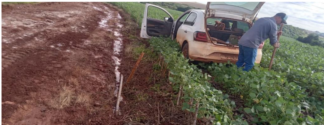
Foto 12 Conserto de rede de água em Vila são Sebastião
