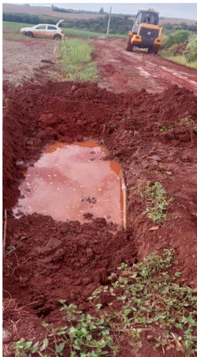
Foto 13 conserto de rede de água em Linha Ardenghi
