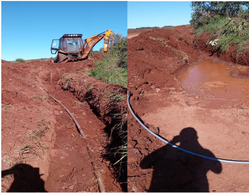
Foto 16 Conserto da rede de água linha correia
