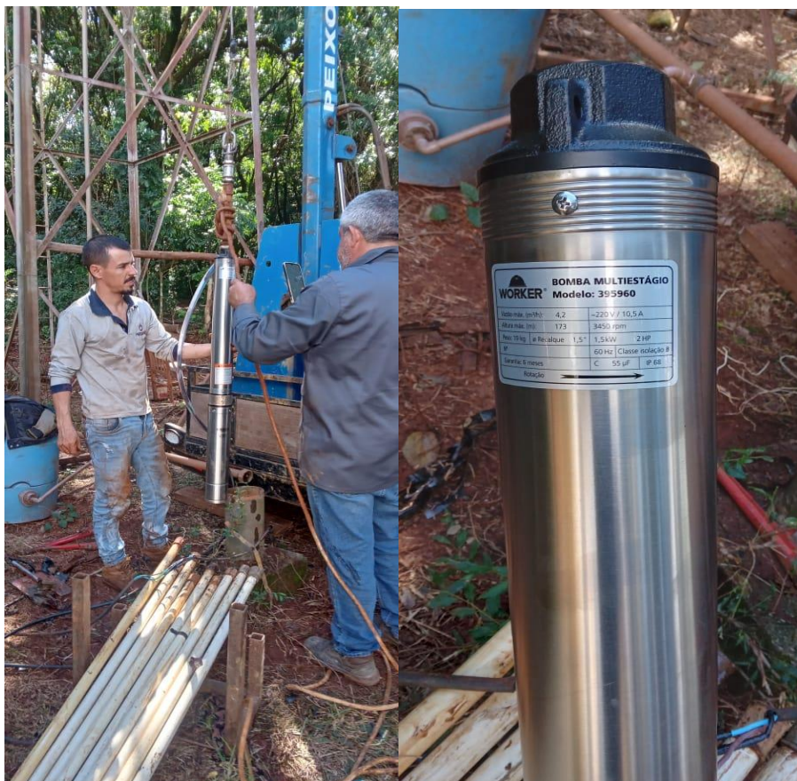
Foto 08 e 09 Substituição de bomba sítio santos
