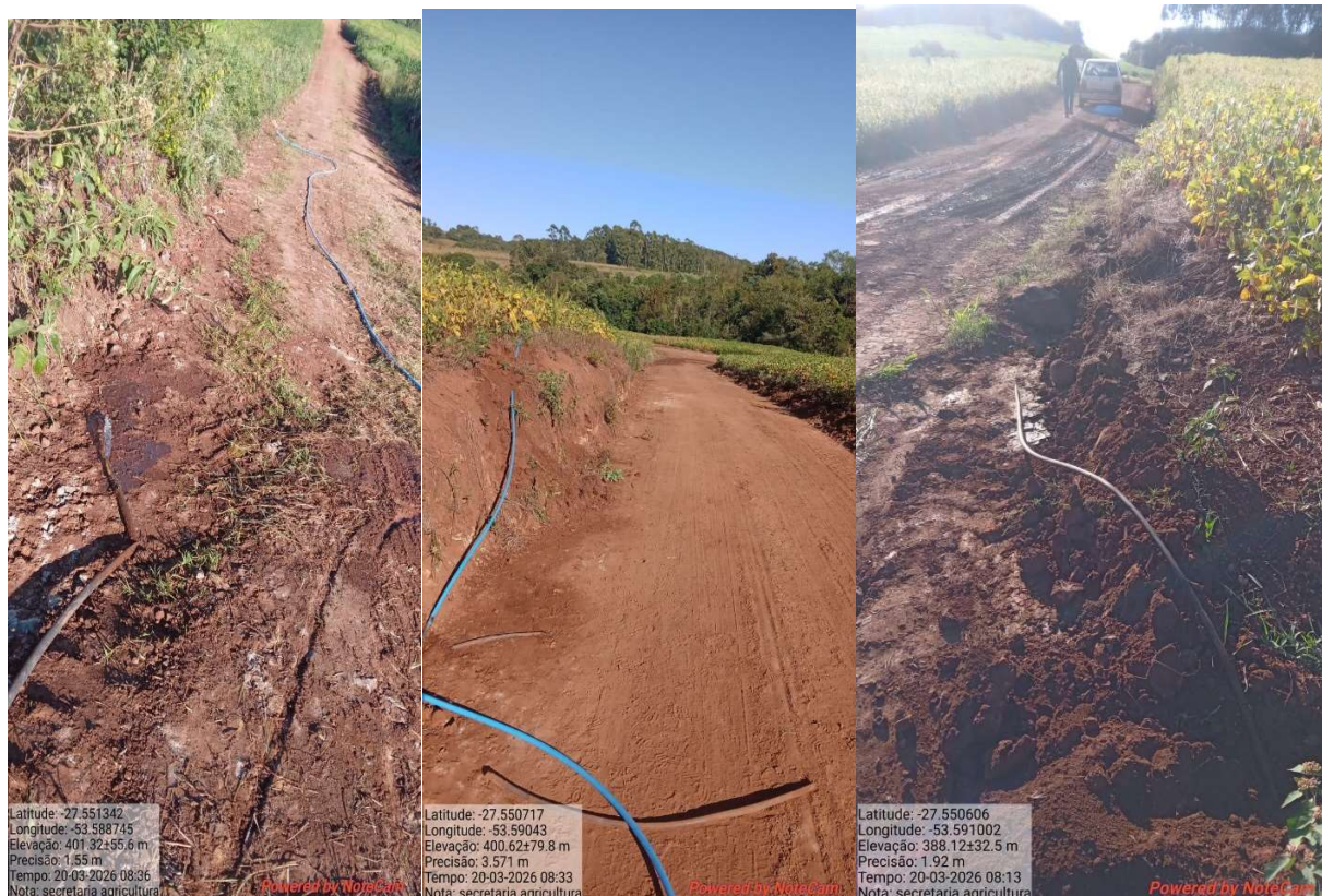
Fotos 28,29,30 Conserto da rede de água linha Marçal 100 metros de mangueira Pead 20 mm
