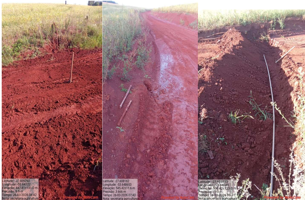
Foto: 40,41,42 Conserto da rede de água comunidade de Vista Alegre
