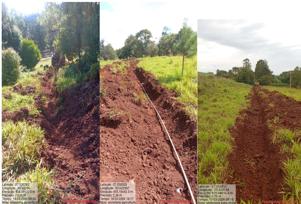
Fotos 34,35,36 Continuação da rede nova de água linha Sítio Casseiro 108 metros de tubo pvc 32mm e 24 metros tubo pvc 40mm e 150 metros de mangueira Pead 25mm
