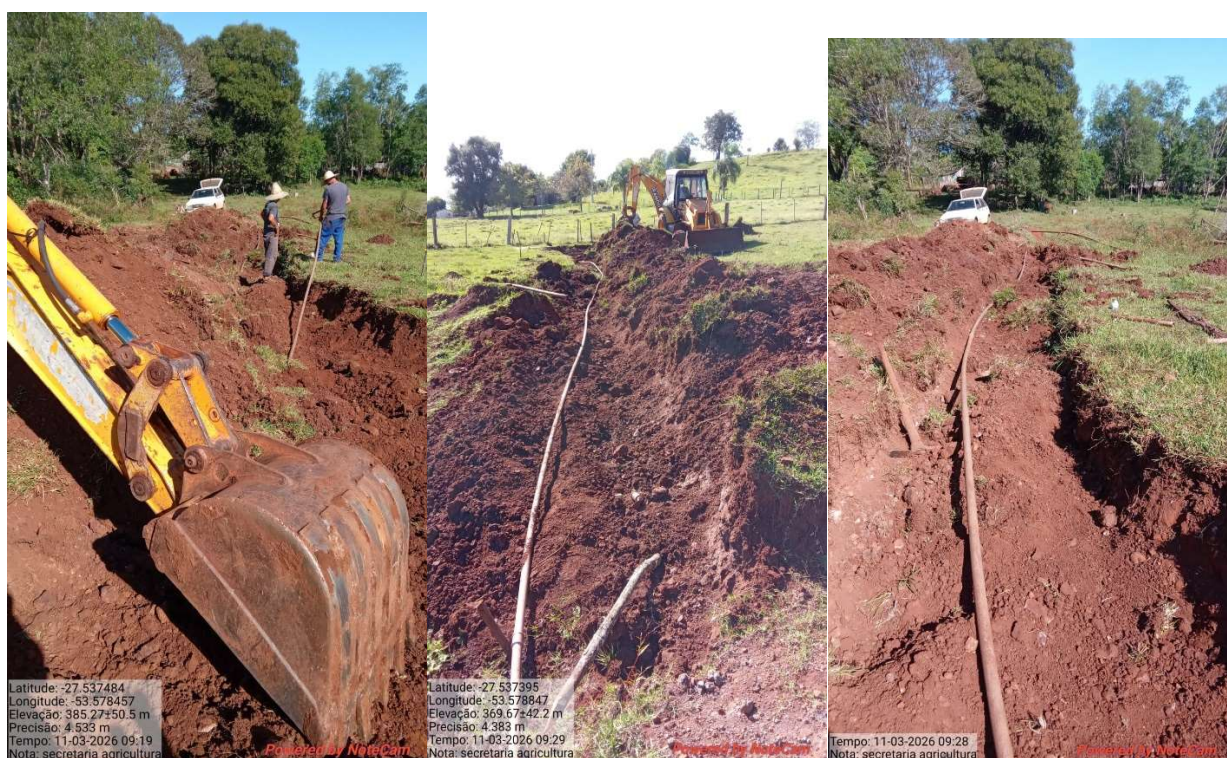
Foto 19,20,21 Reforma da rede de água Linha Terezio 100 metros de tubo pvc 40 mm e 12 metros de tubo pvc 25 mm
