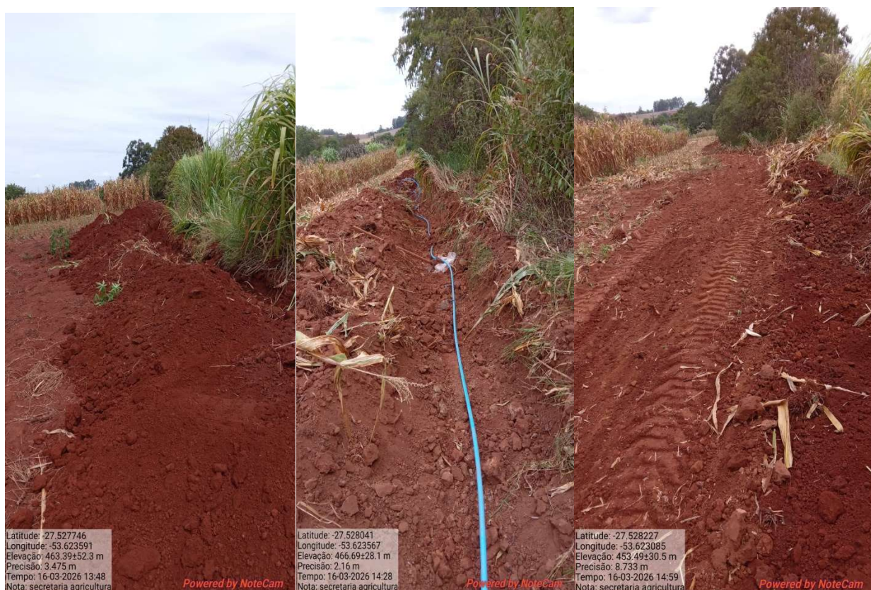
Fotos 37,38,39 Continuidade da rede nova de água linha sítio Casseiro 200 metros de mangueira Pead 25mm
