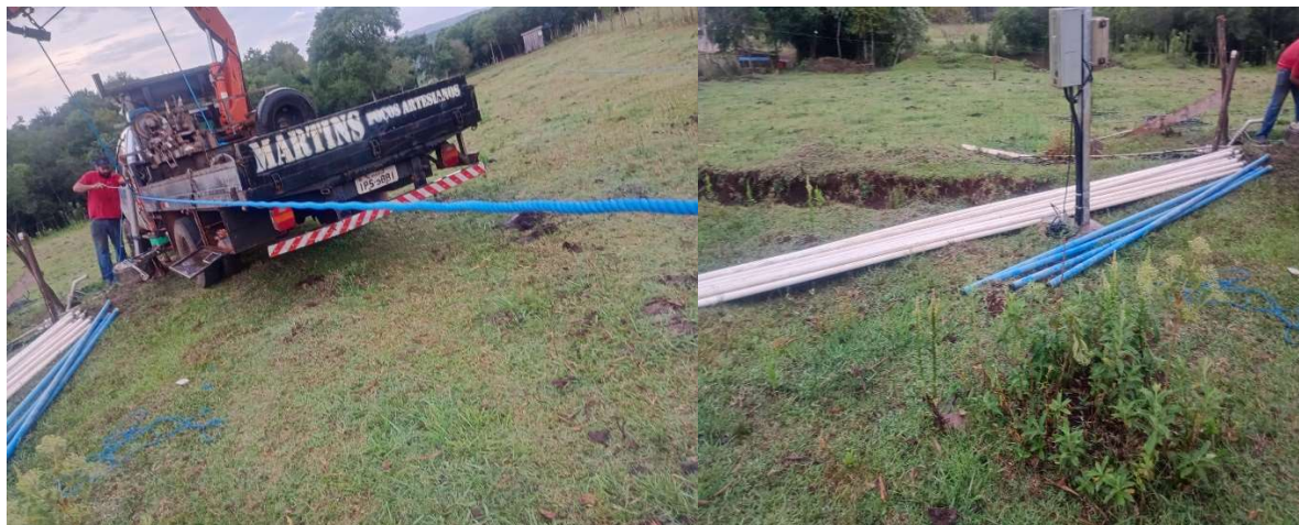
Fotos 49,50,51 Substituição de Bomba de Água Poço Artesiano Conterrâneos
