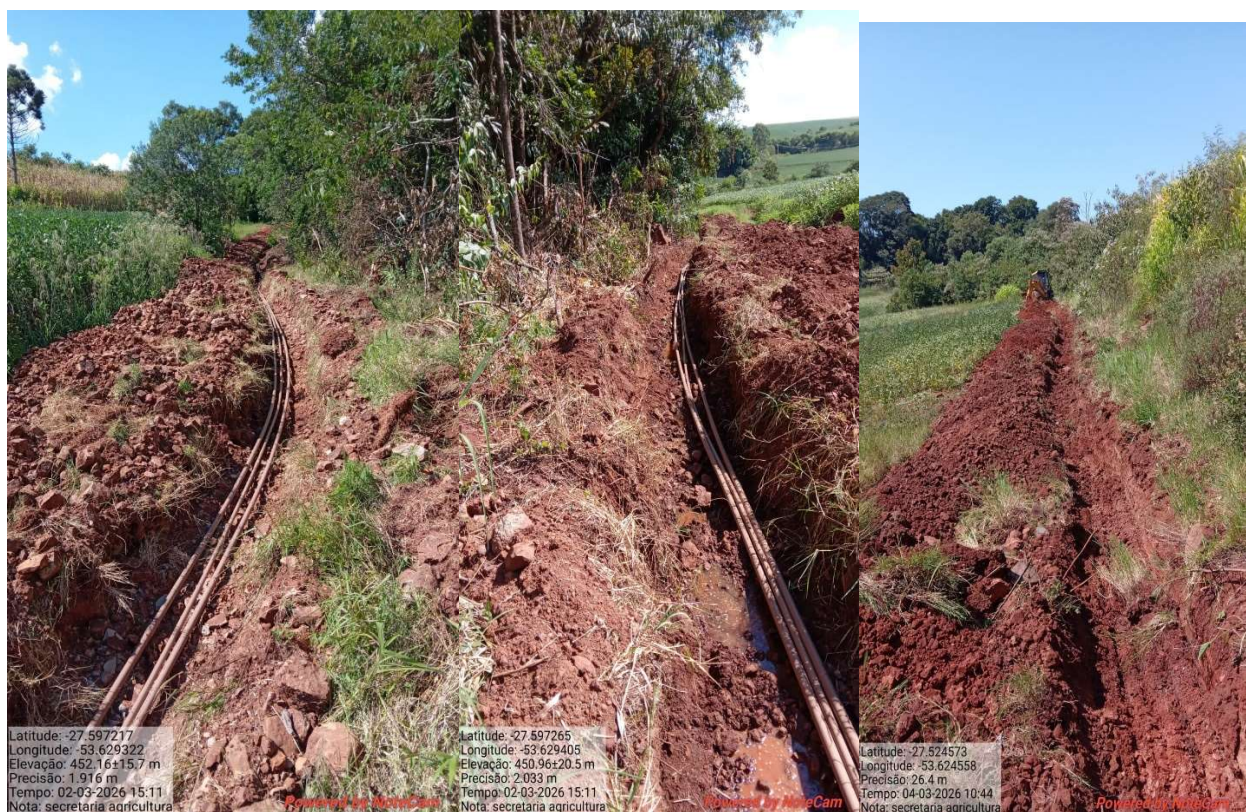
Fotos 13,14,15 Realização da rede de água nova linha Cassemiro 300 metros mangueira Pead 25 mm
