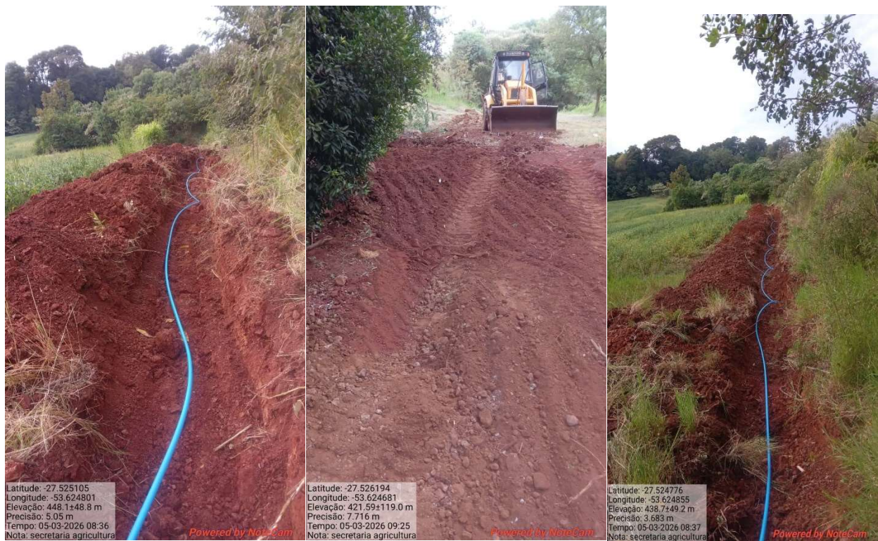
Foto 04,05, 06 Continuação da rede nova de água linha Cassemiro 200 metros de mangueira PEAD 25mm
