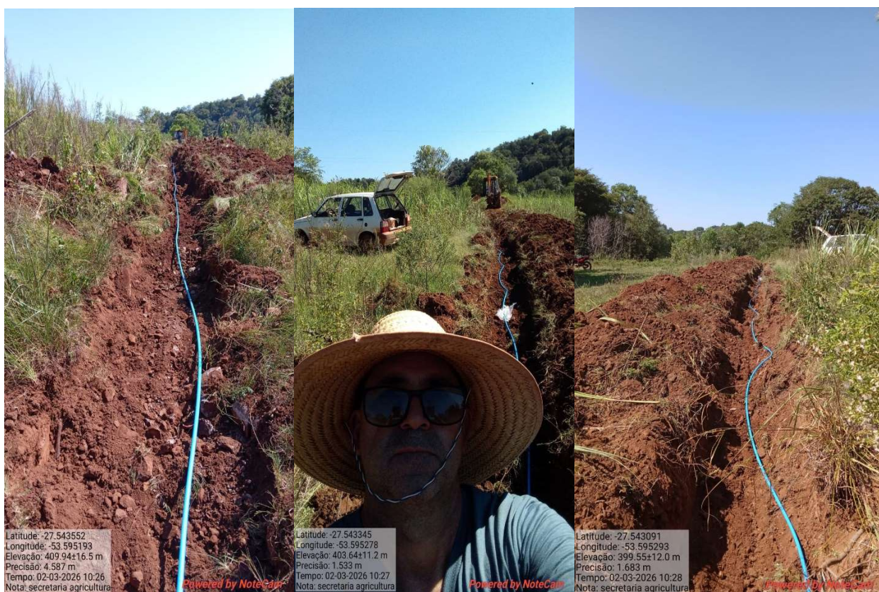
Fotos 25,26,27 Rede nova linha olaia de morais 200 metros mangueira PEAD 20 mm
