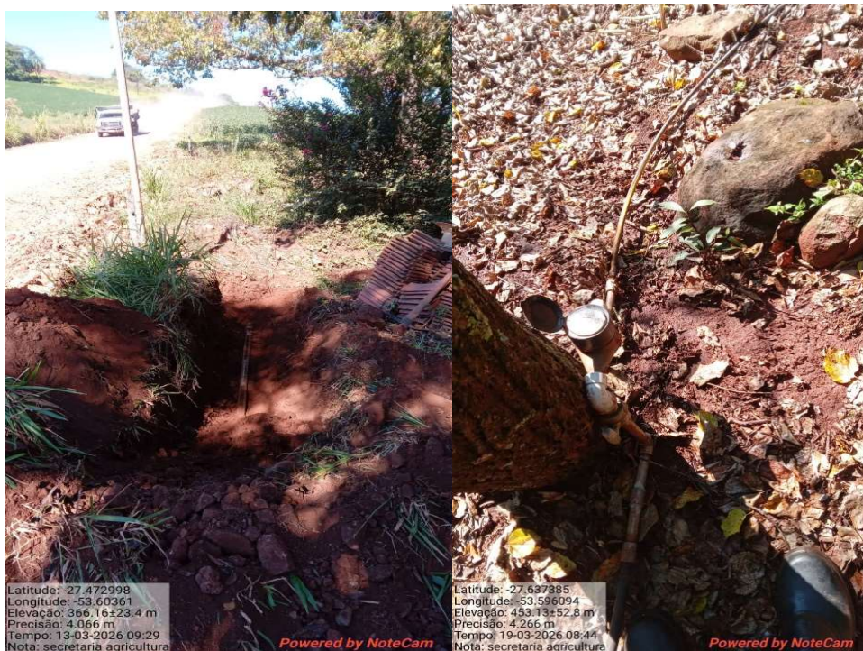
Fotos 53 e 54 Conserto da rede de água linha Manica com colocação de registro na rede e Manutenção e limpeza de Relógio hidrômetro marcador de água linha sítio ouro verde
