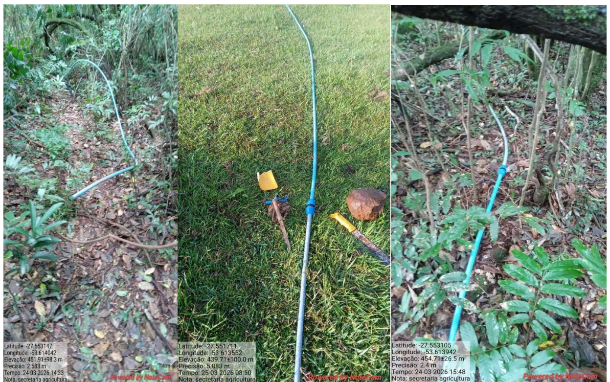
Fotos:43,44,45 Reforma da rede de água linha correia e Acker 100 metros de mangueira Pead 20mm
