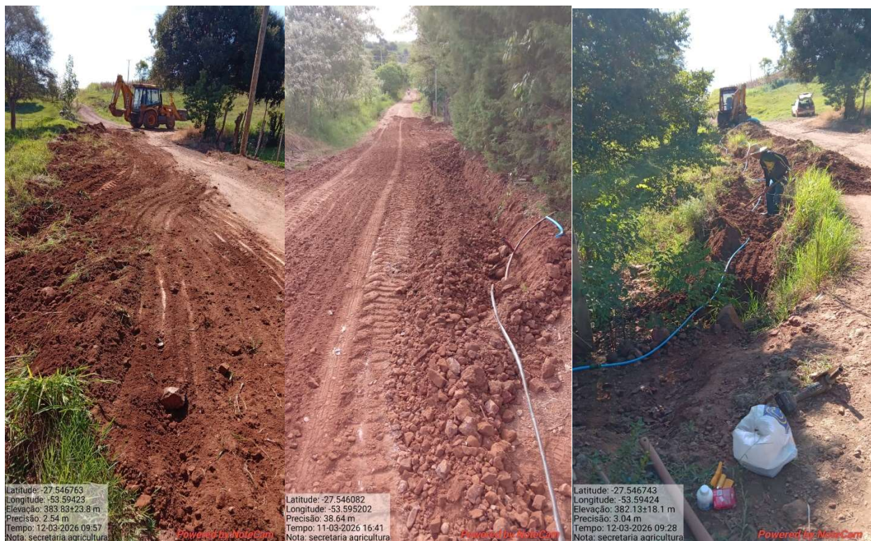
Fotos 10,11, 12 Continuação da rede de água e ampliação da linha Marçal 200 metros de mangueira Pead 20 mm com utilização de peças, conexão T, conexão de emendas com rosca 20mm
