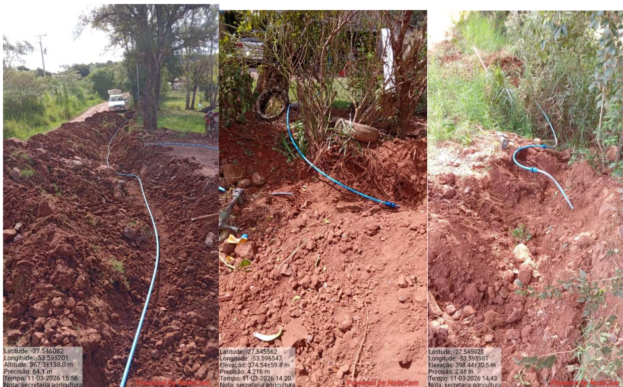
Fotos 22,23,24 Reforma e ampliação com 120 metros de rede de água linha Marçal mangueira Pead 20 mm.
