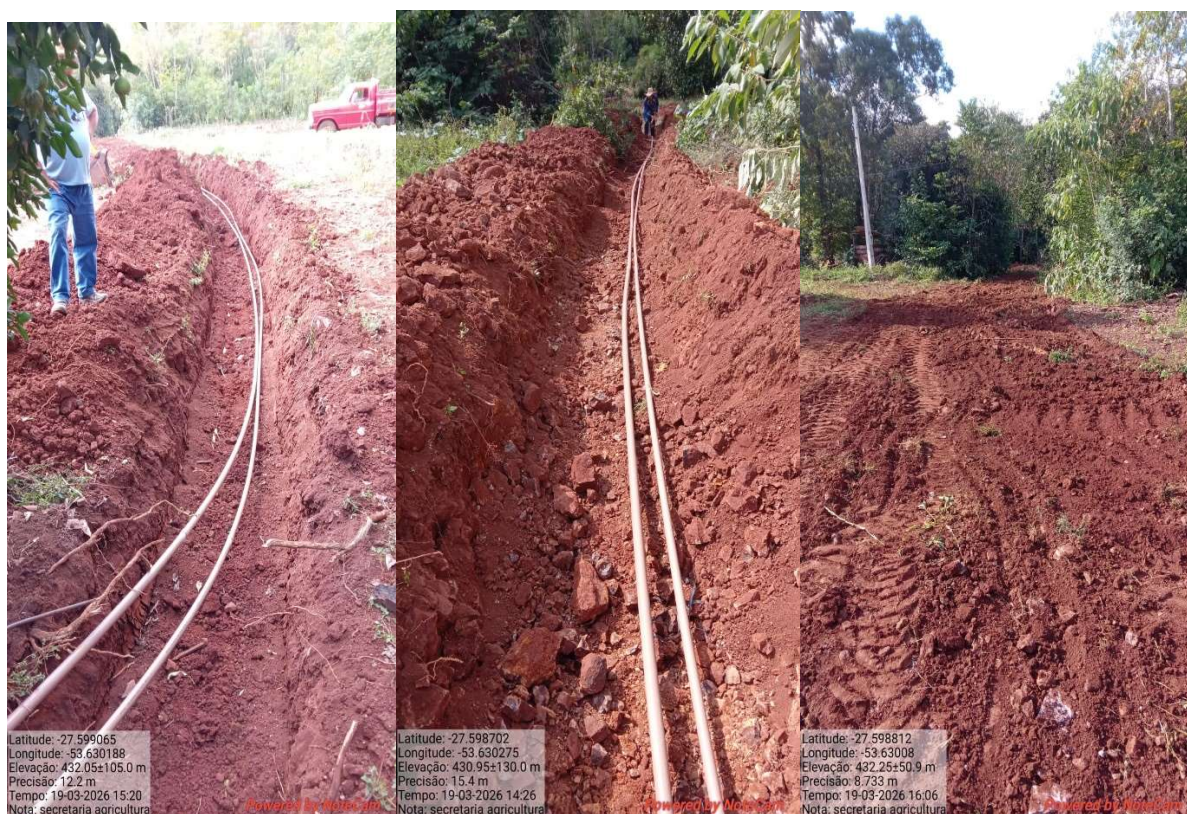
Fotos 31,32,33 Continuação da rede nova de água linha passo do pinheirinho 150 metros tubo pvc 40 mm
