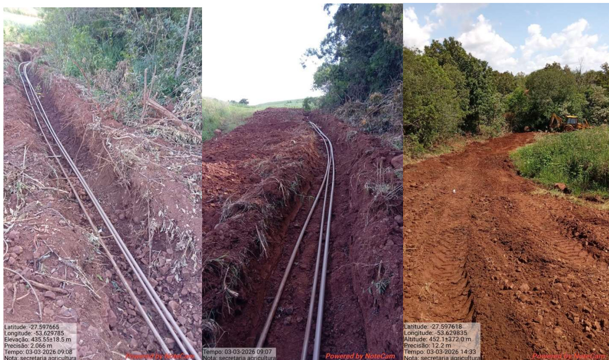
Fotos 16,17,18 Realização da rede de água nova linha Cassemiro 300 metros mangueira PEAD 25mm
