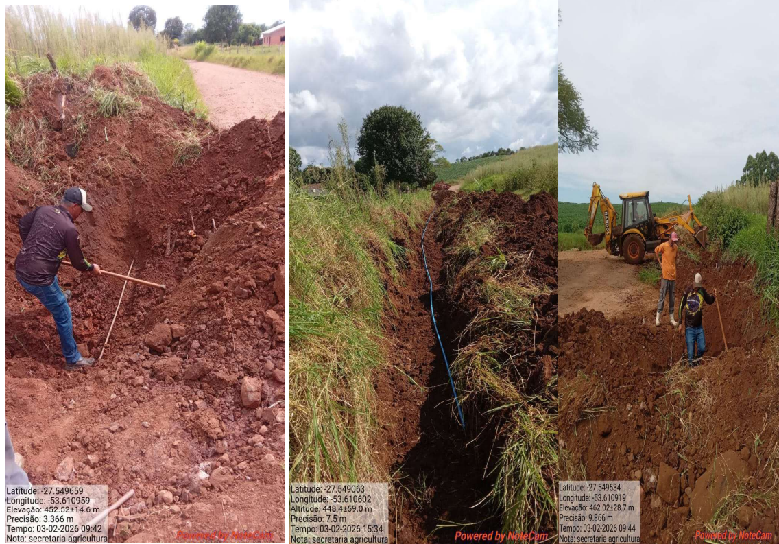
Fotos 03,04 e 05 Realização de ampliação da rede de água linha Acker correia
