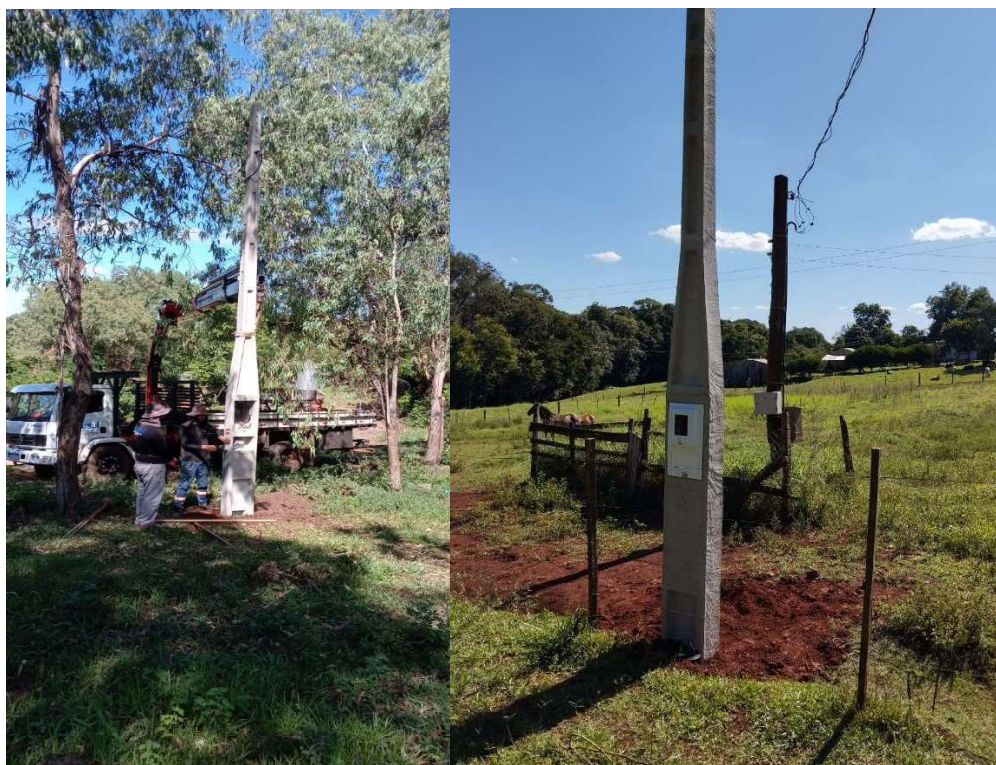
Fotos 10 e 11 Instalação de poste novo em poço artesiano localizado na comunidade de Vista Alegre e Sítio Cassemiro
