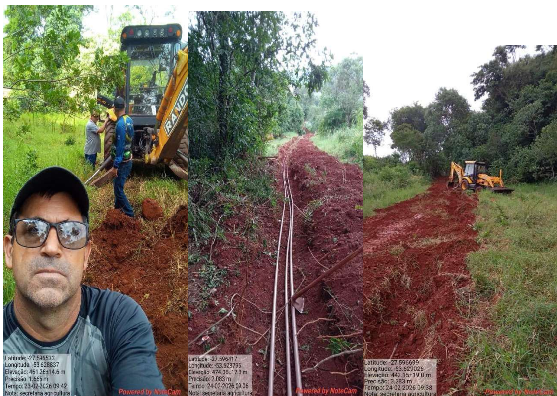
Fotos 15,16 e 17 Início de instalação de rede nova de agua em Passo Pinheiro com 330 metros de rede onde foi utilizado tubos soldáveis de 32 mm e 40 mm
