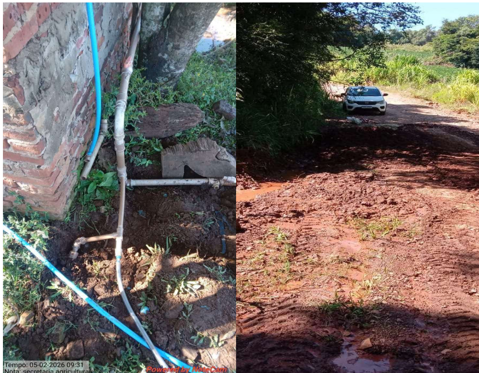
Fotos 08 e 09 Conserto da rede de água Viana e Conserto da rede de água linha cacique Double
