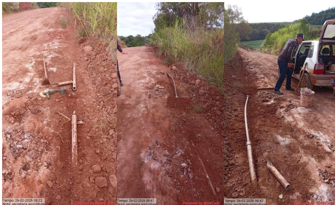
Fotos 12,13 e 14 Reparos de rede de agua na comunidade de Linha Manica.
