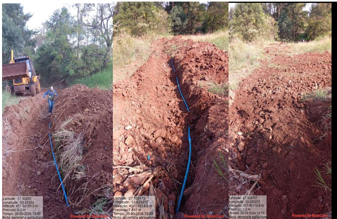
Fotos 15,16 e 17 Continuação da rede nova de água em sítio Cassemiro
