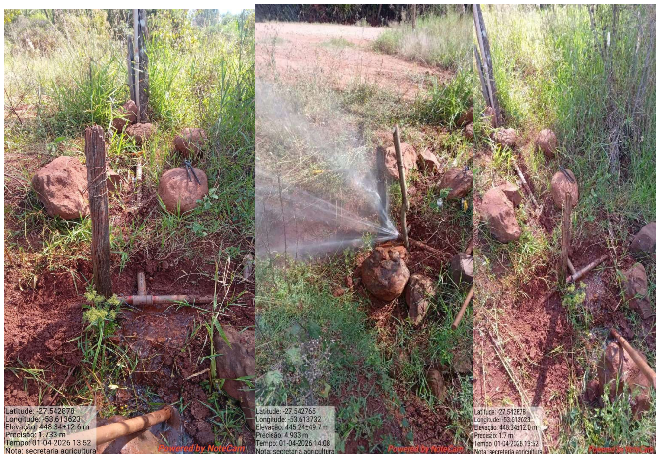
Fotos 09,10 e 11 manutenção da rede de água em Vila Ottonelli
