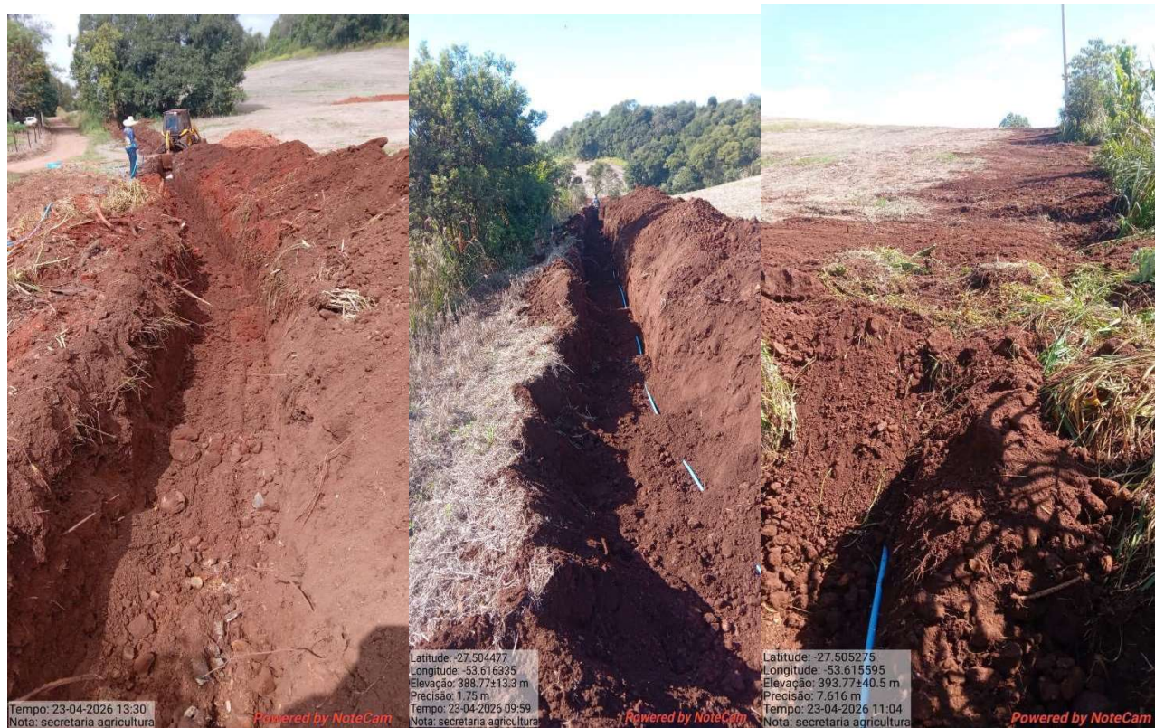
Foto 18,19 e 20 Serviços de aberturas de valetas e cobertura das mangueiras de Pead 25 mm em Linha Terezio com 1100 metros de rede
