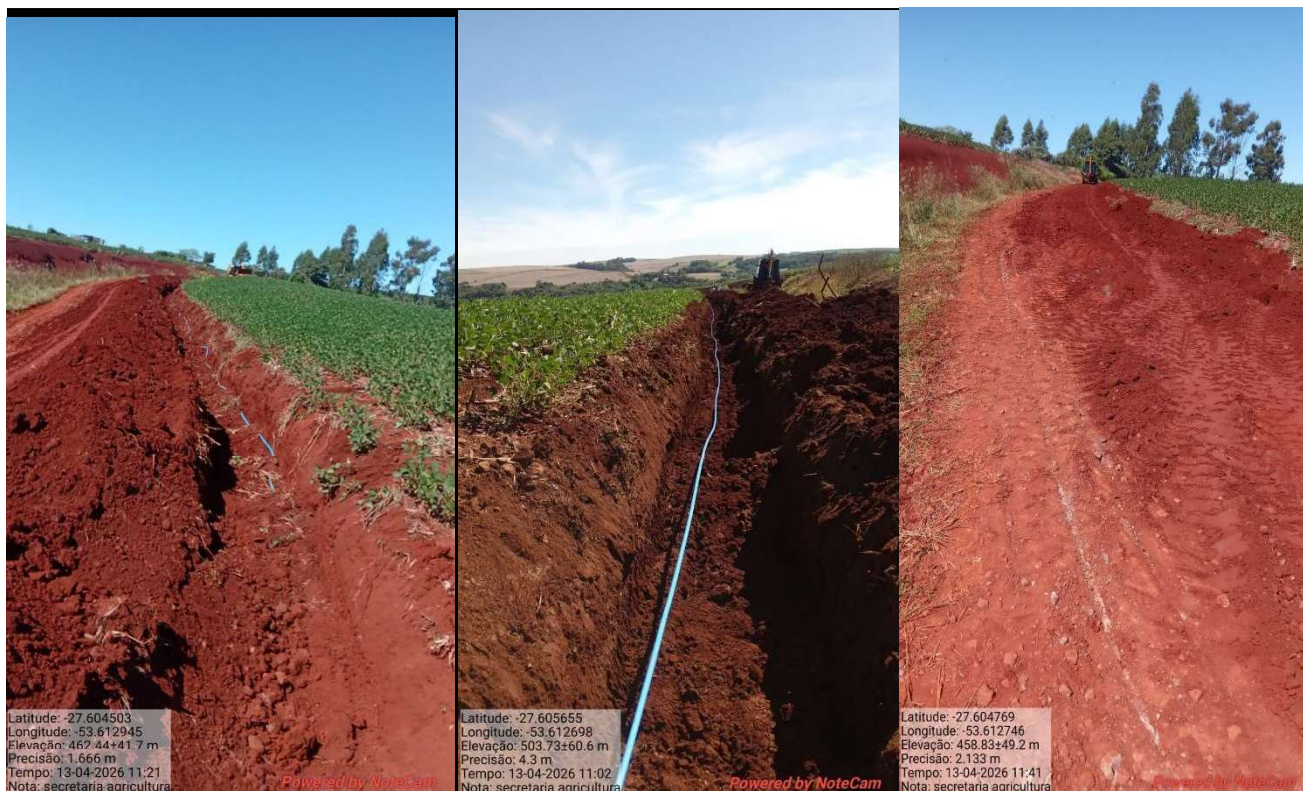
Fotos 12,13 e 14 abertura da nova rede água linha Richter 1200 metros de mangueira Pead de 20 mm
