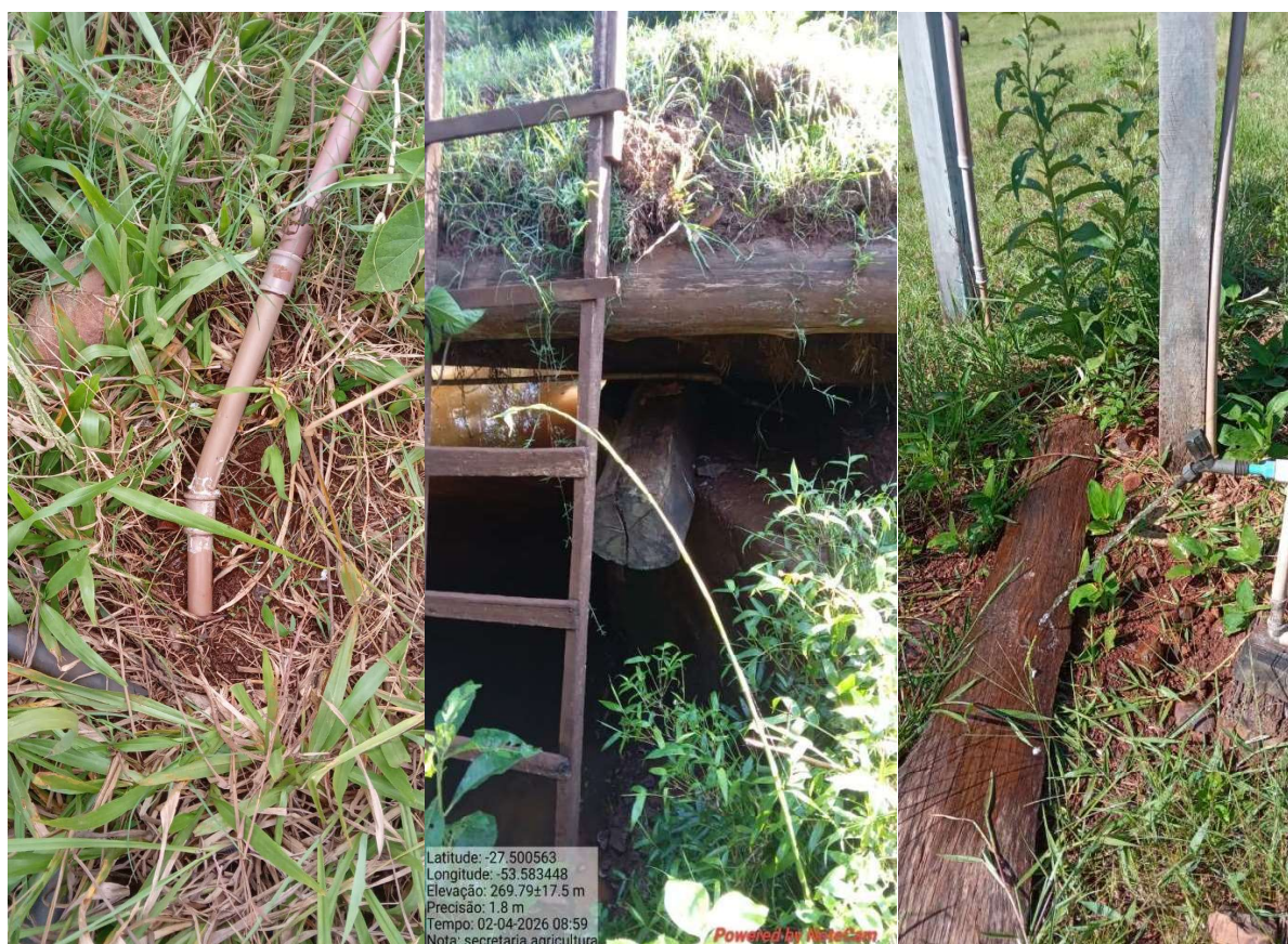
Foto 03,04 E 05 Manutenções de redes de água em Linha Olaia de Moraes, Linha São José e Linha Soledade
