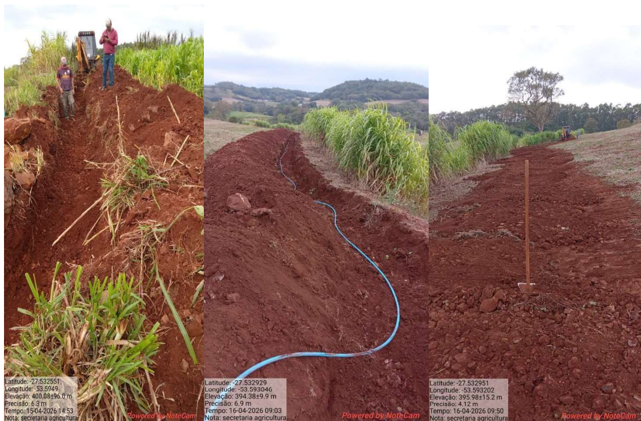
Foto 18,19 e 20 Serviços de aberturas de valetas e cobertura das mangueiras de Pead 25 mm em Linha Terezio com 1100 metros de rede
