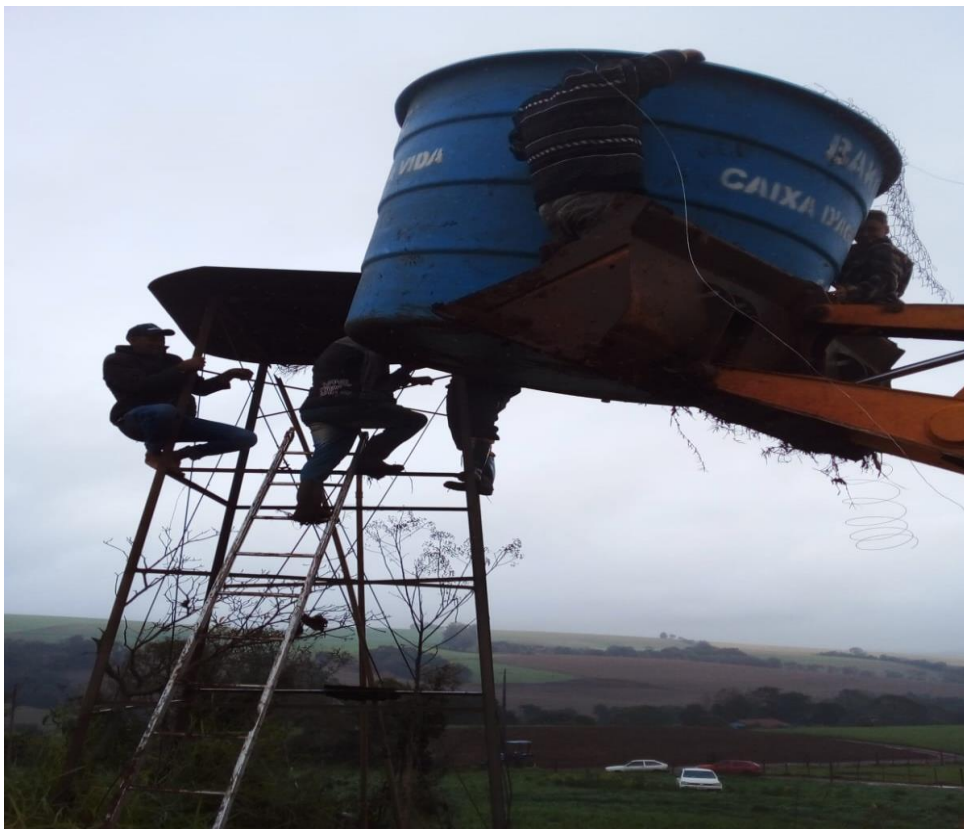
Foto 11 Substituição de caixa em Sítio Ienerich
