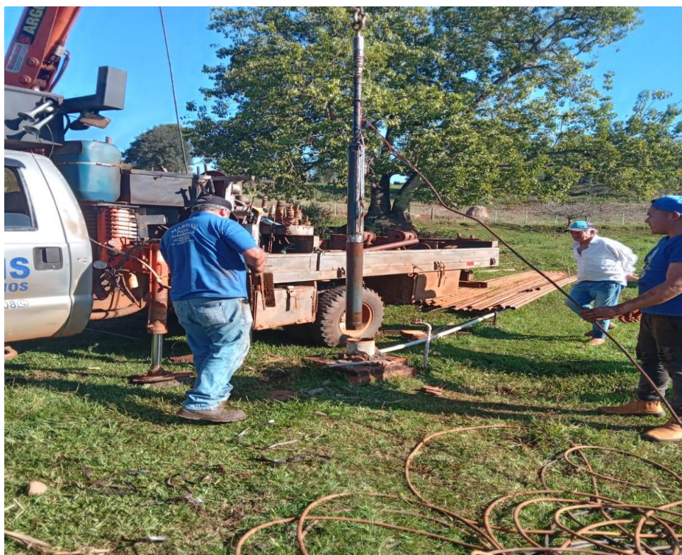
Foto 7 instalação de bomba de agua em Linha Terezio
