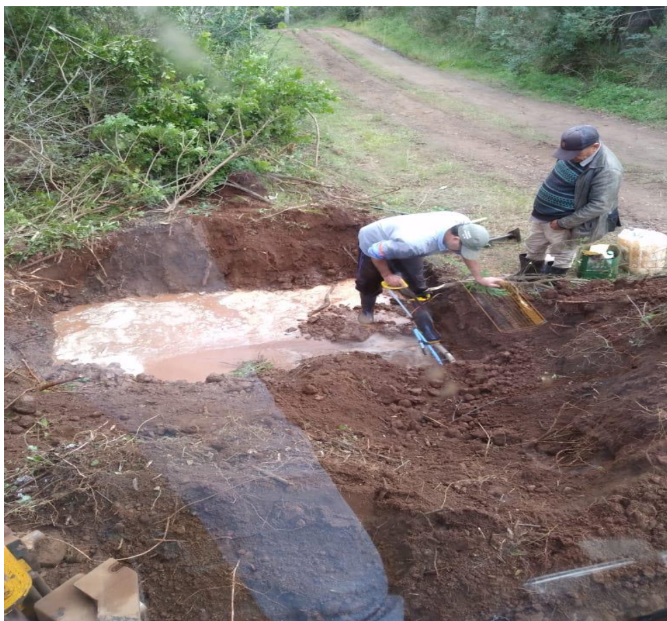
Foto 09 Instalação de 200 metros de rede em Linha São Jose
