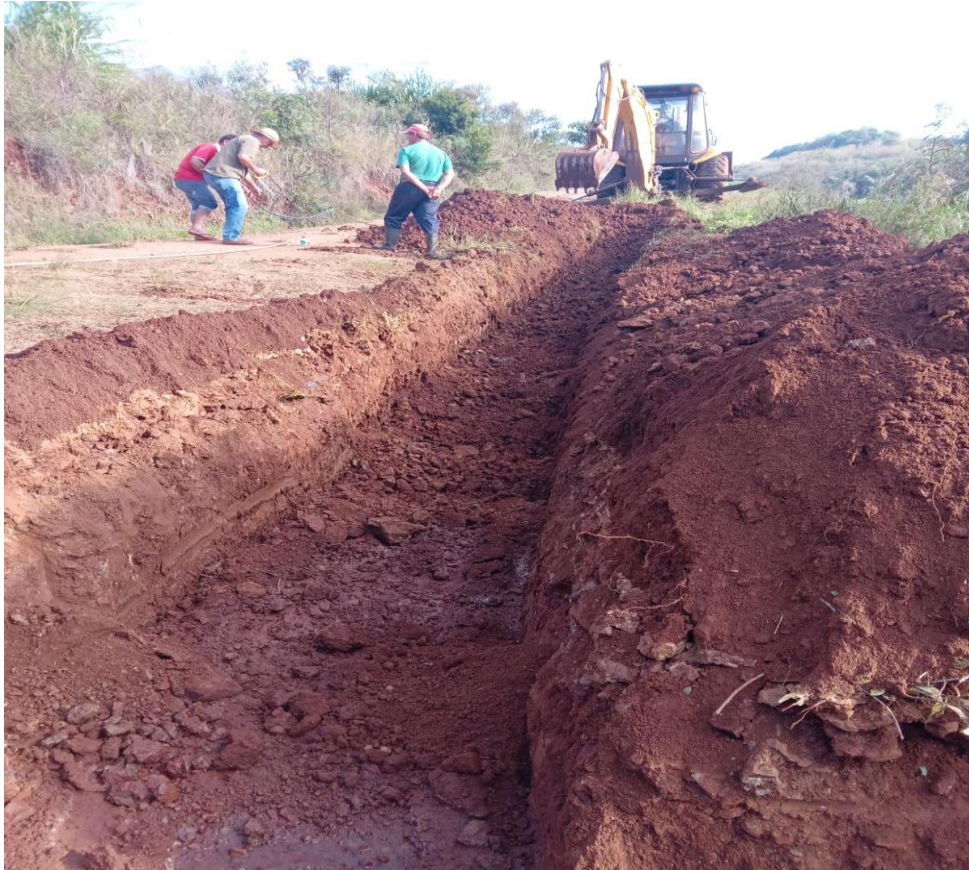
Foto 10 Instalação de 300 metros de rede em Linha Aparecida
