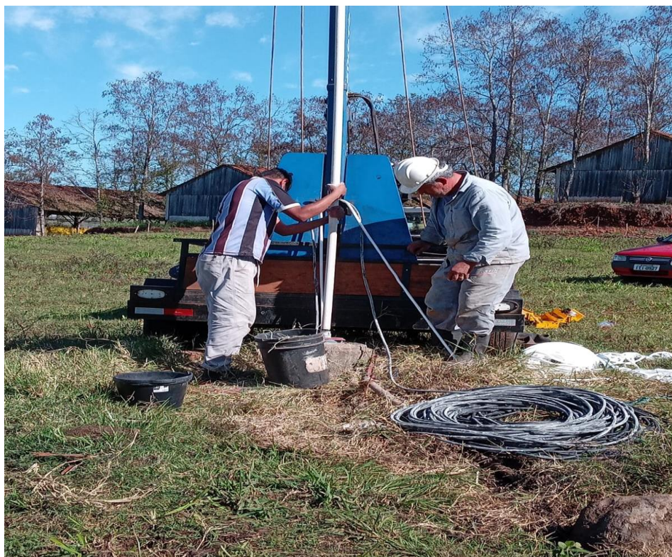
Foto 04 Instalação de bomba em Linha São José
