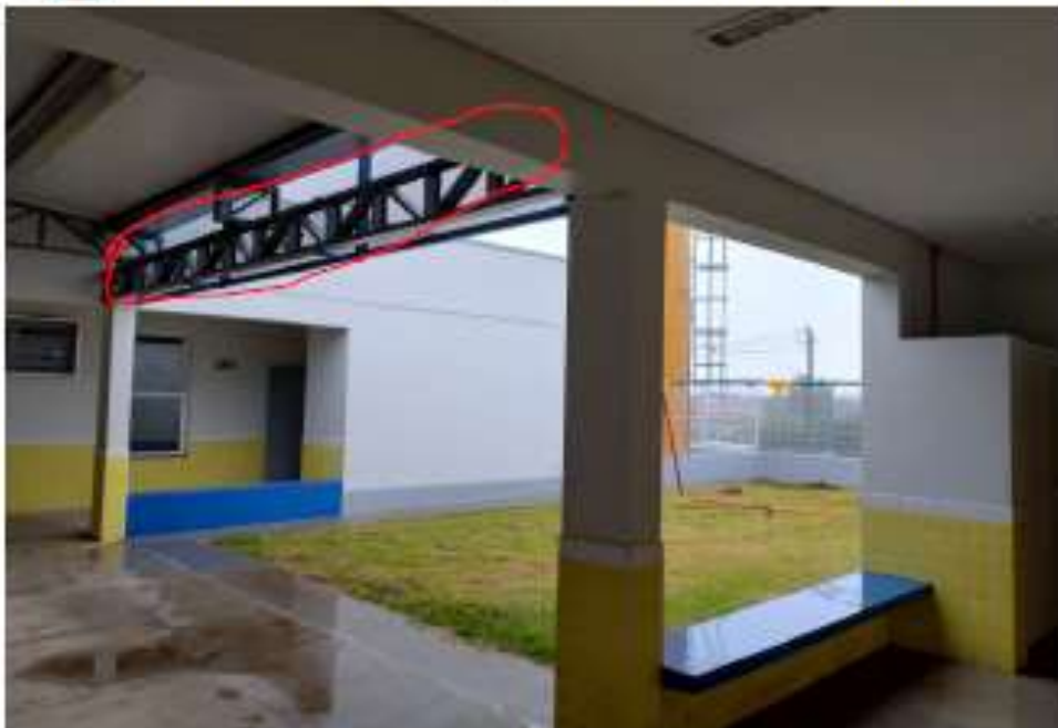
Foto 06 – Fechamento chapa galvanizado. 02 unidades
