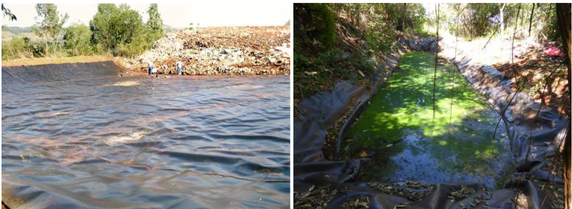
Figura 2.16 – Lagoa de tratamento de percolados junto ao aterro municipal de Porto Lucena.
