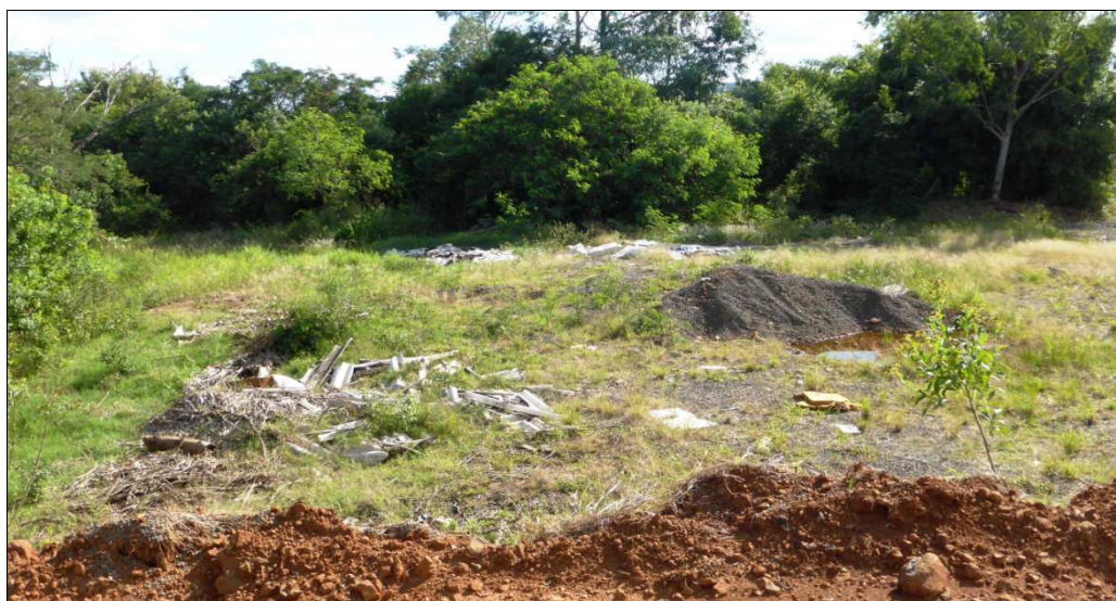
Figura 2.21 – Local para disposição de Resíduos da Construção e Demolição (RCD).
